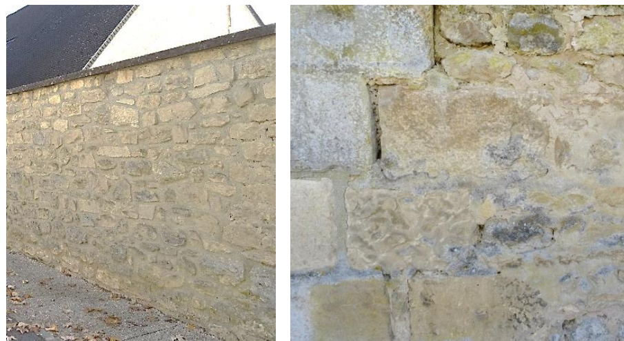
Mur de clôture en moellon de pierre calcaire, beige grisé et beige doré
