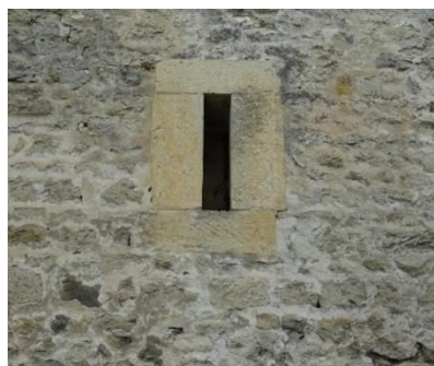
Mur en maçonnerie de moellons de pierre et encadrement de baie en pierre de taille, de calcaire doré 2, Place Henri IV à Châlons-sur-Vesle
