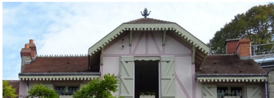
Lambrequins, crêtes et épis de faîtage sur une toiture en petites tuiles plates à Chenay
