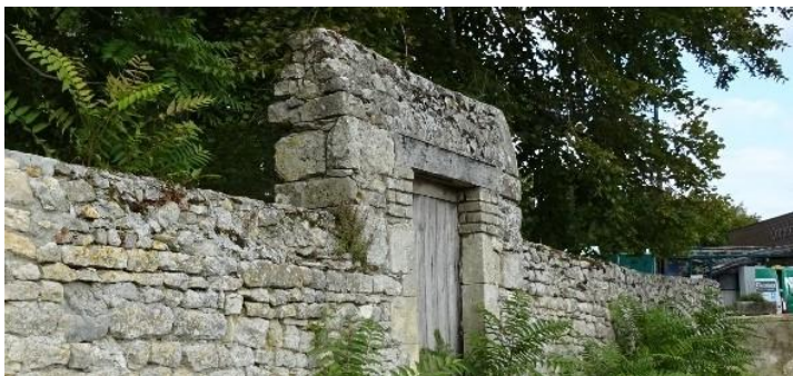
(1) Couronnement de mur en maçonnerie de moellons de pierre en tas de charge
