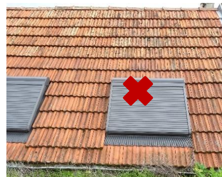
Châssis surmonté par un volet roulant, interdit car faisant saillie par rapport au plan de la toiture
