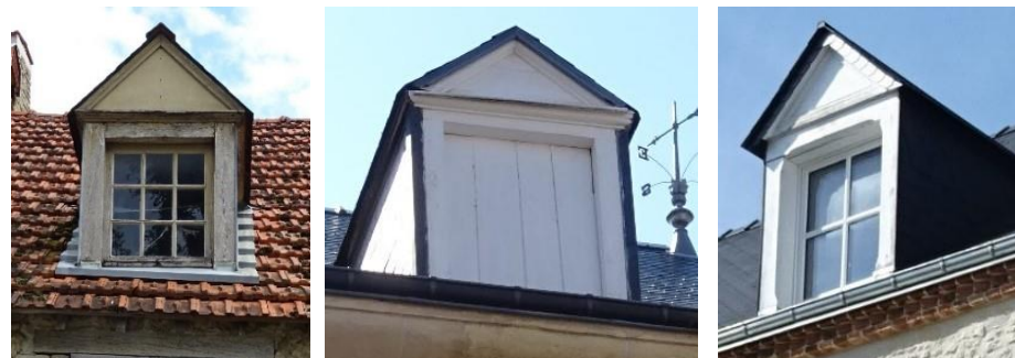
Lucarnes en bois à bâtière et à fronton triangulaire
