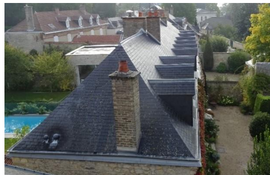
Toiture en ardoise, 20, rue Général Leclerc à Chenay avec ses souches de cheminées et ses lucarnes
