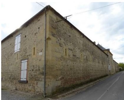
Mur en maçonnerie de moellons de pierre et encadrement de baie en pierre de taille, de calcaire doré 2, Place Henri IV à Châlons-sur-Vesle
