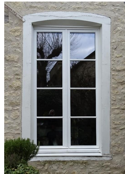
Fenêtre en bois à grand carreaux
