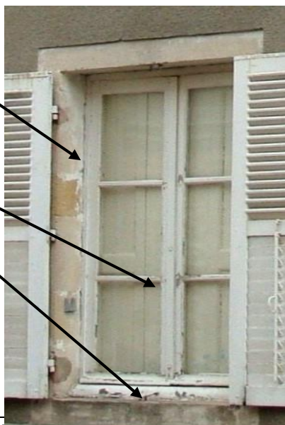
Exemple de fenêtre en bois peint
