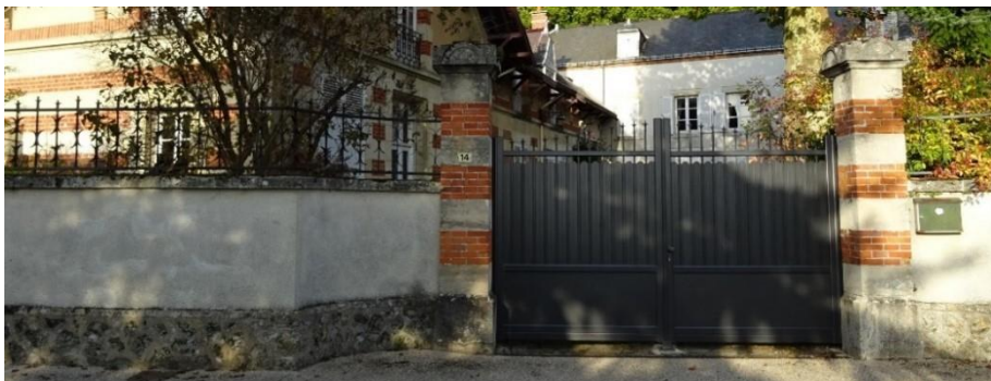
Mur composé d'une maçonnerie de pierre meulière et d'une maçonnerie enduite surmontées d'une grille en ferronnerie- rue du Gal Leclerc à Chenay.
