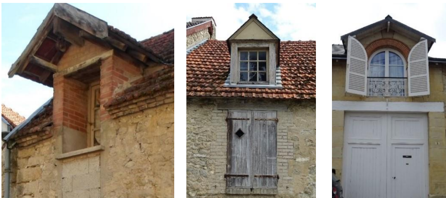
Exemples de lucarne sur les bâtiments intéressants
