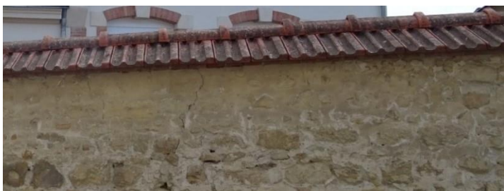
(4) Un chaperon en tuiles mécaniques dont le faîtage est recouvert d'une tuile faîtière à bourrelet de recouvrement
