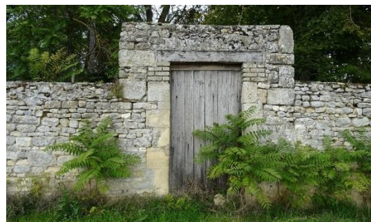
Exemple de porte en bois constituée de planches verticales, chemin de la Couture à Trigny
