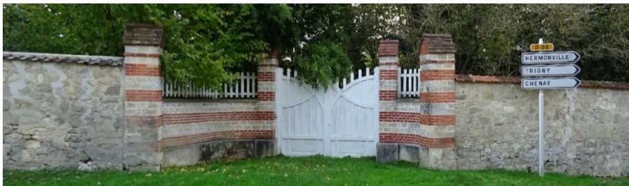
Mur en maçonnerie de pierre et en brique rouge et brique jaune
