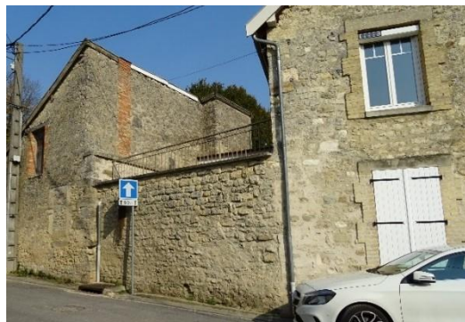
Exemple de toiture terrasse non visible du domaine public et masquée par un mur de clôture en maçonnerie et surmonté d'une grille en ferronnerie
