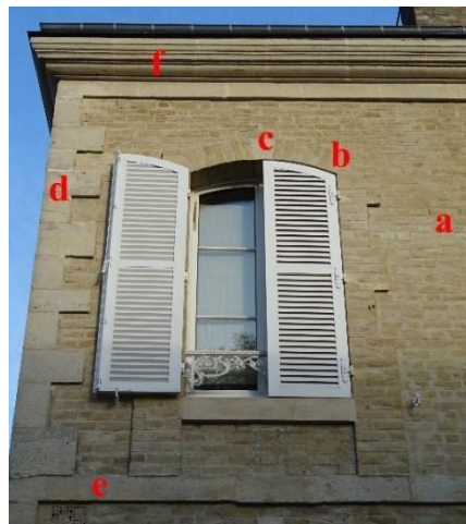
Maison bourgeoise 1, rue du Cimetière à Chenay : Construction avec une toiture à 4 pans - Maçonnerie de brique silico-calcaire (a), encadrements de baie et linteaux segmentaires en brique silico-calcaire (b) et une clé de voute en pierre (c) ; Chainage harpé en pierre de taille de calcaire (d) ; Bandeau en pierre de taille (e) ; Corniche en pierre de taille moulurée (f) ; Lucarne à fronton en pierre de taille calcaire (g) ; Piliers de portail en pierre de taille (h) et portail en serrurerie (i) .
