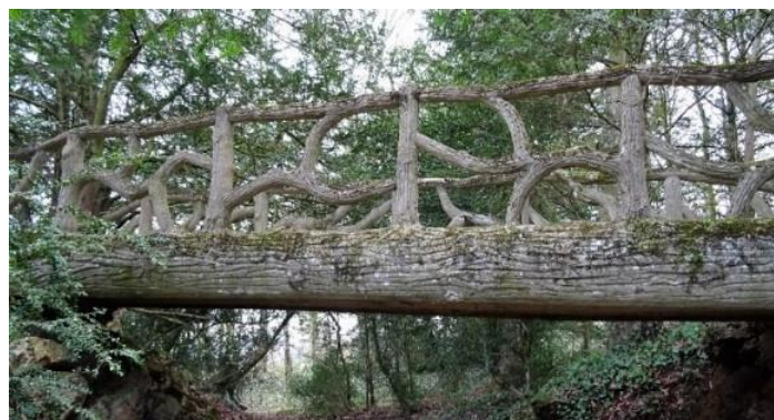
Garde-corps en béton moulé ferrailé, imitant les troncs d'arbres
