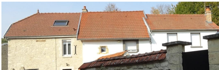
Couverture en tuile mécanique à côte sur des « bâtiments intéressants » à Chenay
