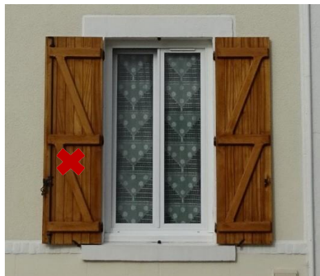
Les volets lasurés et les écharpes sont interdits
