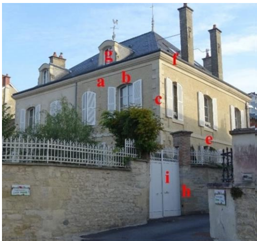
Maison bourgeoise 1, rue du Cimetière à Chenay : Construction avec une toiture à 4 pans - Maçonnerie de brique silico-calcaire (a), encadrements de baie et linteaux segmentaires en brique silico-calcaire (b) et une clé de voute en pierre (c) ; Chainage harpé en pierre de taille de calcaire (d) ; Bandeau en pierre de taille (e) ; Corniche en pierre de taille moulurée (f) ; Lucarne à fronton en pierre de taille calcaire (g) ; Piliers de portail en pierre de taille (h) et portail en serrurerie (i) .
