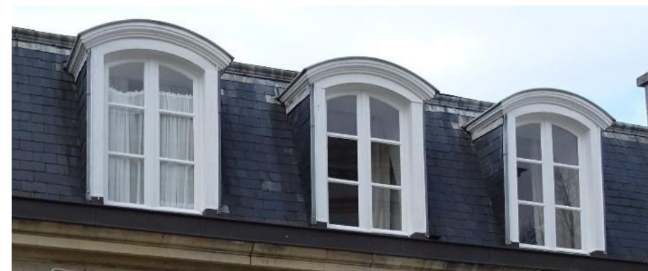
Lucarnes en bois avec linteau cintré
