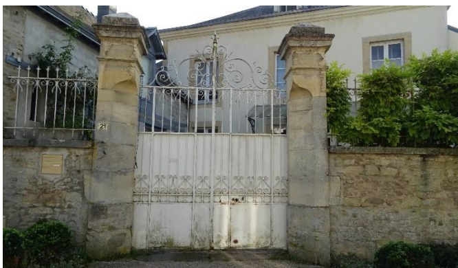
Mur composé d'une maçonnerie de pierre meulière et d'une maçonnerie enduite surmontées d'une grille en ferronnerie- rue du Gal Leclerc à Chenay.
