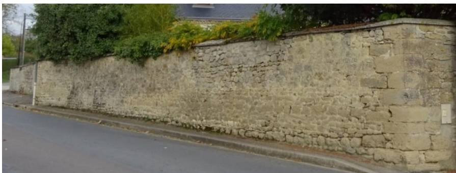
(1) Mur de clôture constitué de moellons de pierre appareillés en assises régulières et achevé par un joint « à cru » - Rue St Marguerite à Châlons-sur-Vesle
