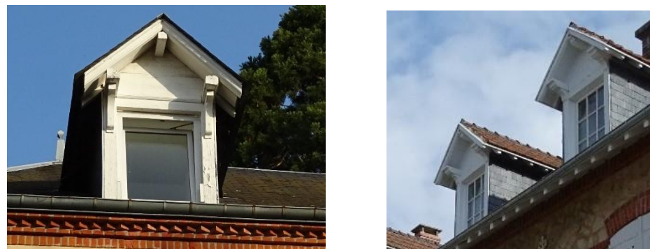
Lucarne en bâtière en bois formant une avancée avec les abouts de panne supportés par des consoles
