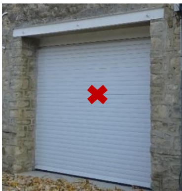
Exemples de porte de garage et de fermeture de baie avec un volet roulants PVC, interdits
