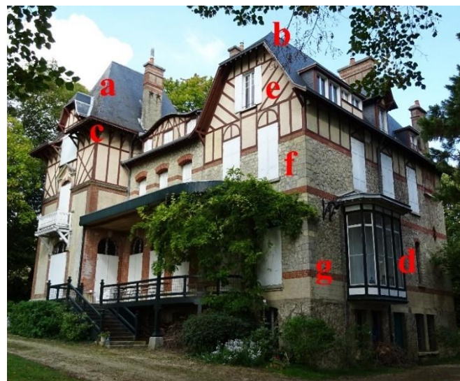
Villa 4, rue St Nicolas Chenay : Construction couverte par une toiture à croupe (a), une toiture à demi-croupe (b) avec des débords de toit (c) ; Oriel (d) ; Pan de bois (e) ; Maçonnerie de moellons de pierre en opus incertum (f) ; Bandeaux de brique rouge (g) ;
