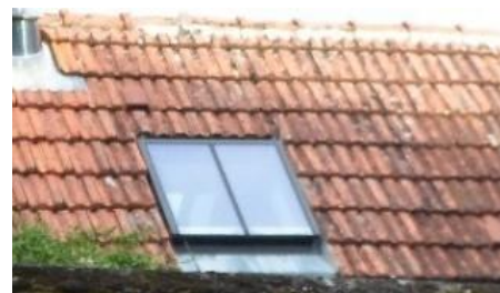
Châssis de toit métallique de type patrimoine avec un meneau central assimilé aux anciennes tabatières
