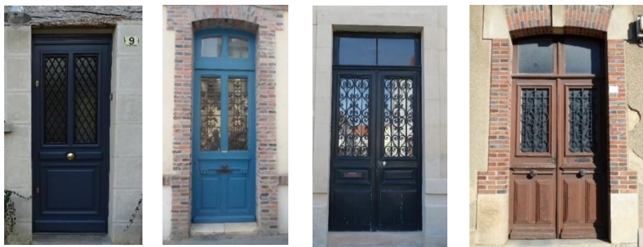
(4) Exemples de portes composées de panneaux moulurés, la partie supérieure vitrée et protégée par des grilles en fer forgé ou en fonte moulée
