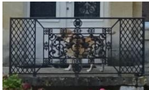
Exemple de garde-corps en ferronnerie
