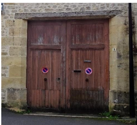
(1 ) Exemples de portes charretières composées de planches verticales assemblées et percées par un portillon
