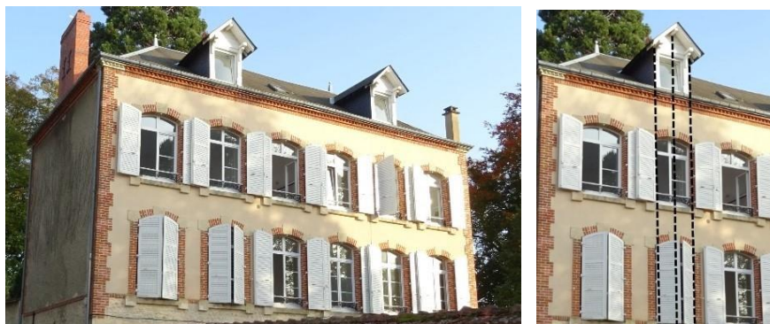
Lucarne axée sur la baie inférieure - la largeur de la lucarne, y compris les jambages, est légèrement inférieure à la largeur de la fenêtre.
