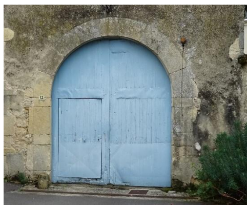
(1 ) Exemples de portes charretières composées de planches verticales assemblées et percées par un portillon
