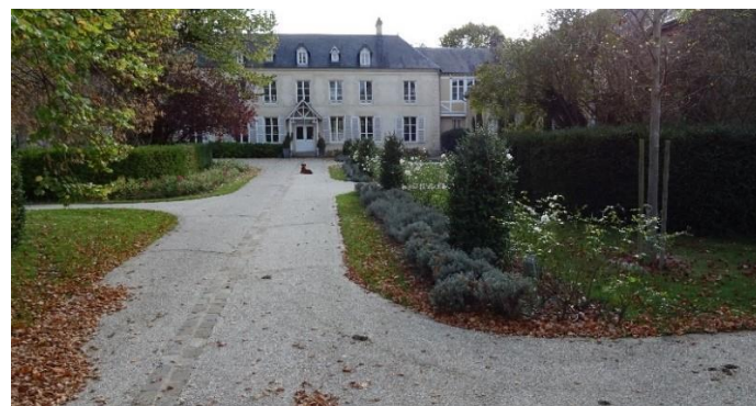
Allée de béton de gravillons lavés, soulignée par un caniveau en pavés de grès, rue de l'Église à Châlons-sur-Vesle
