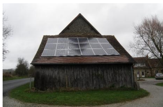
Figure 92 : Installation solaire photovoltaïque à Mieuxcé
