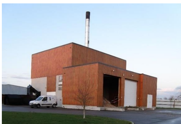
Figure 88 : Chaufferie-bois de Courteille
