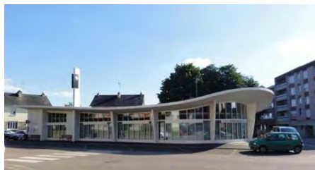
Figure 160 : Le bâtiment de France télévision
