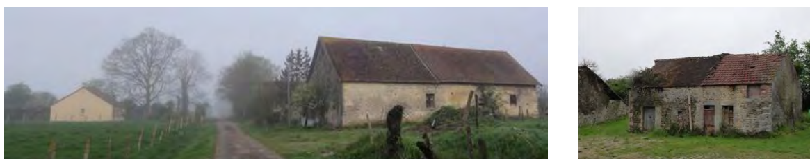
Figure 69 : Anciens bâtiments agricoles
