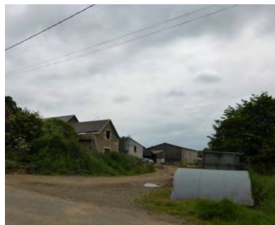
Bâtiments agricoles sur le plateau
