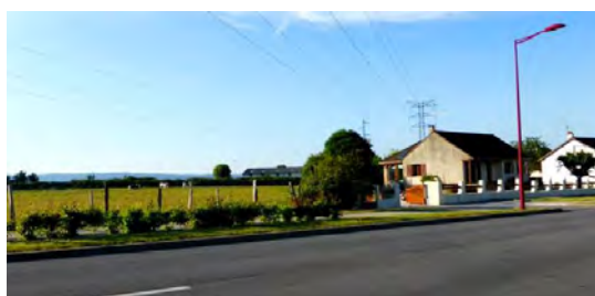
Ligne électrique en entrée de Saint-Germain-du-Corbéis
