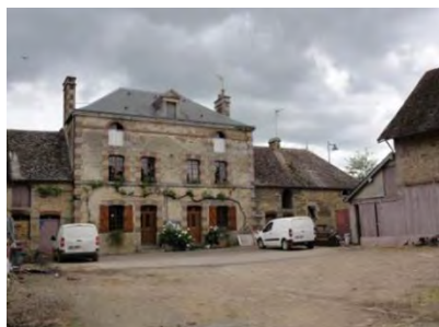
Figure 133 : Ferme moderne dans le bourg de Cuissai
