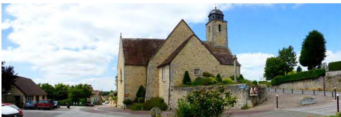
Figure 205 : Église de Condé-sur-Sarthe et ses abords
