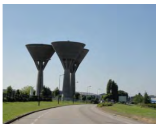
Figure 161 : Les trios de château d'eau
