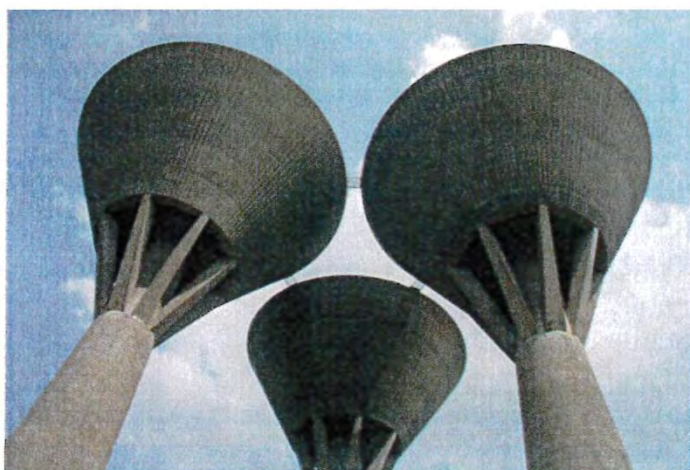
Châteaux d'eau situés ZI Nord
