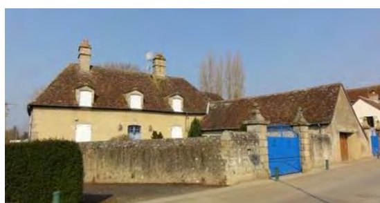
Figure 110 : Maison de maître à Valframbert
