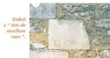
Avant de commencer tout enduit, il est indispensable de faire faire plusieurs échantillons et de les laisser sécher plusieurs jours. Il faut obtenir un échantillon pleinement satisfaisant avant de commencer le travail.
