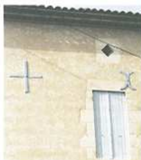
Enduit de chaux aérienne et de sable sur moellons, venant se raccorder exactement au niveau des pierres de taille.
