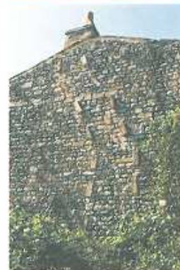
Conduit de cheminée tardu
