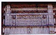
Porche en pierre ouvragée
