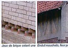
Jeux de brique créant une aération
