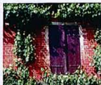
Brique recouverte d'un lait de chaux
