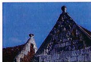
Pointes de pignon avec fleurs du maçon
