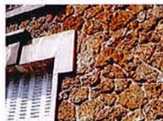
Meulière avec joint creux au mortier bâtard
