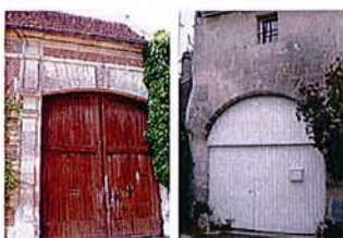
Porche d'entrée avec encadrement ouvragé en pierre
