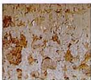
Enduit ancien sur moellon
