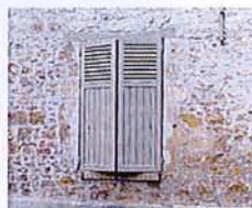
Maçonnerie moellon à pierre vue
