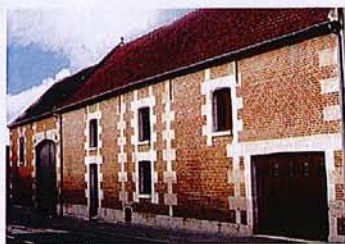
Réutilisation d'une grange en logement
