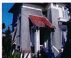
Entrée avec auvent en tuile mécanique
