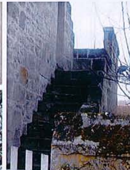
Escalier en pierre sur pignon
