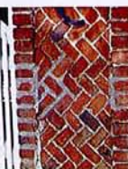
Brique rouge unie, silico-calcaire claire, vernissée et cintrée, badigeonnée en rouge, posée à chevron, formant un escalier ou un couronnement de clôture
