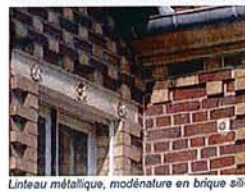
Linteau métallique, modénature en brique silico-calcaire et brique argile
