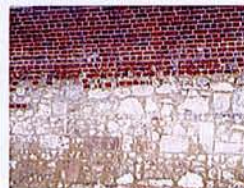
Brique et moellon calcaire
