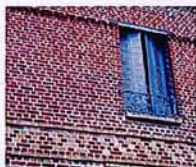
Brique rouge, brique silico-calcaire blanche
