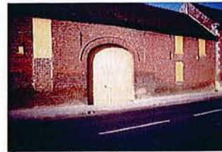
Grange avec porte charretière
