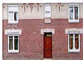
Mur en brique rouge et silico-calcaire
