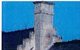
Souche de cheminée en pierre de taille
