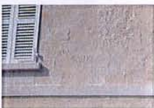
Ravalement d'enduit sur moellon
