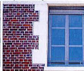
Ravalement de mur de brique, joints à la chaux avec un appareillage paneress/boutisse, occultation par un store intégré
