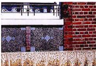
Modénatures : céramiques, bandeaux, corniches, harpes, encadrements
