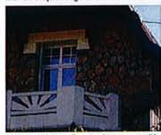
Balcon en béton d'une maison en meulière
