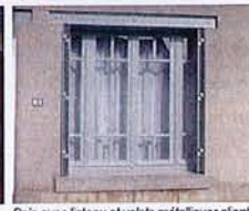
Baie avec linteau et volets métalliques pliants
