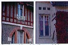
Façade en enduit mouchetés et faux pans de bois
