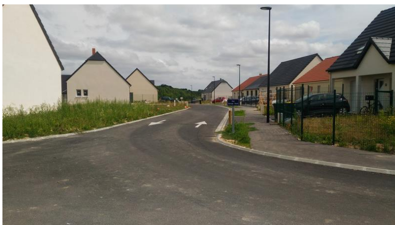
Figure 30 : Exemple d'un lotissement contemporain
