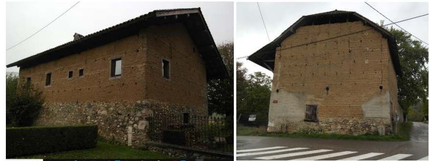
Bâti isolé en pisé
