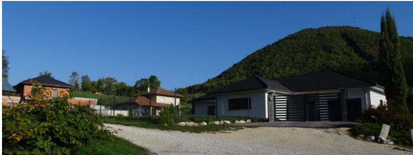
Diversité des formes, de l'aspect et de l'implantation des constructions
