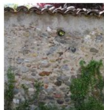
05 : le mur, une fortification ?
