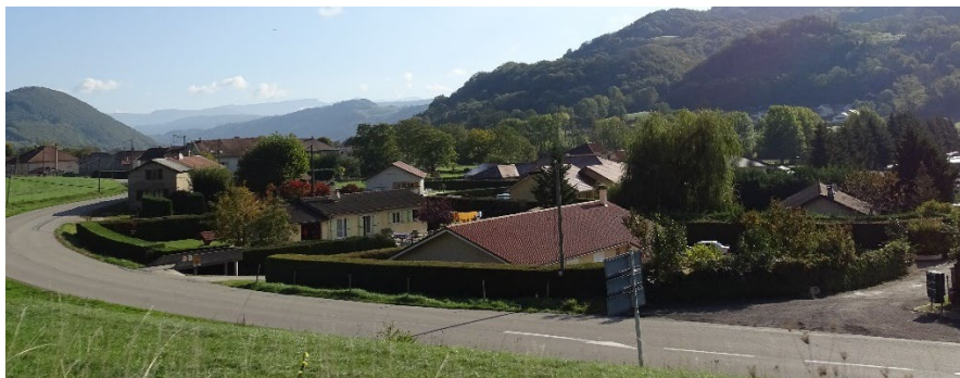
Extension récente de l'Arsenal (Epode, 2022)
