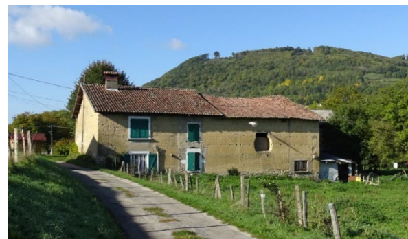
Bâti traditionnel en pisé
