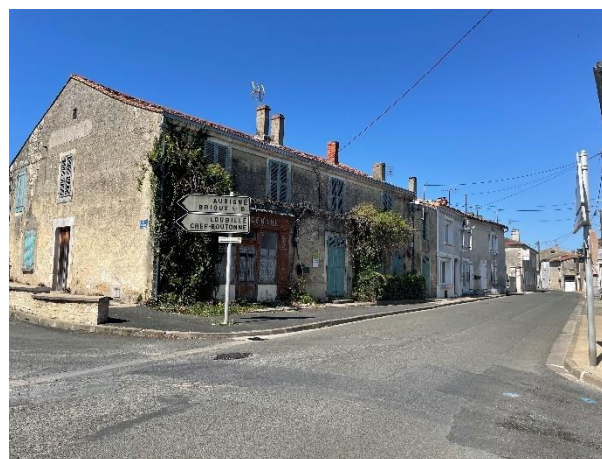
Logement vide, Couture d'Argenson
