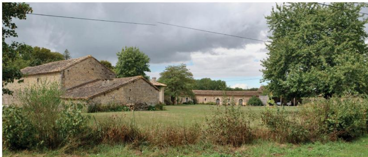
Ci-dessous, des maisons d'habitation enduites en calcaire, bâtiments annexes en maçonnerie de moellons, jambages et angles en pierre de taille, Périgné
