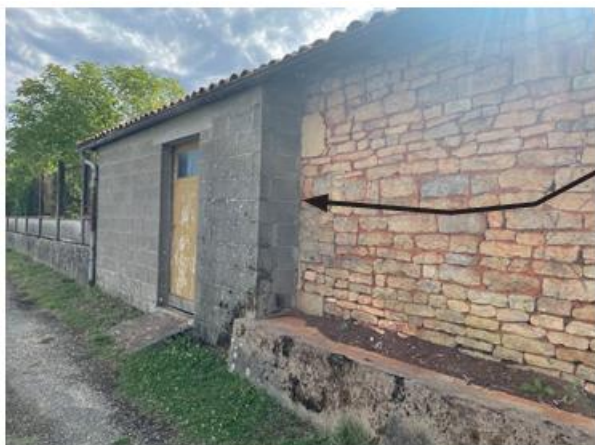
Extension en parpaings non enduits d'un mur ancien traditionnel
