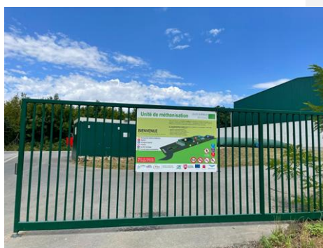
Unité de méthanisation à Celles-sur-Belle
