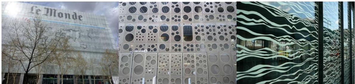
Sérigraphie et revêtement anticollision avifaune (source : LPO Loire et Vogelwarte)
