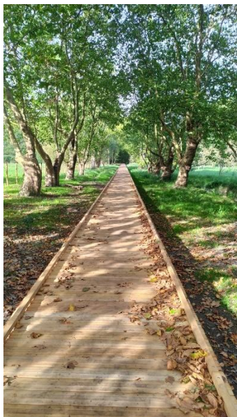
Platelage bois assurant la continuité écologique et hydraulique à la montagne (source, Cittànova, M. PIED)
