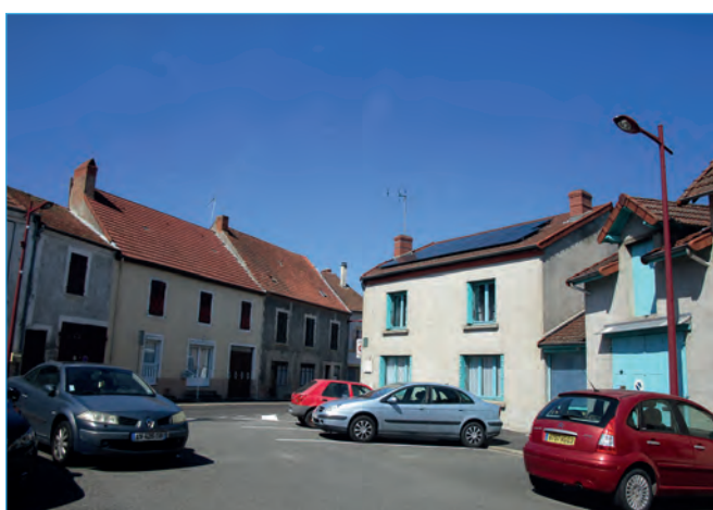
Exemple dans le centre-bourg de Le Breuil
