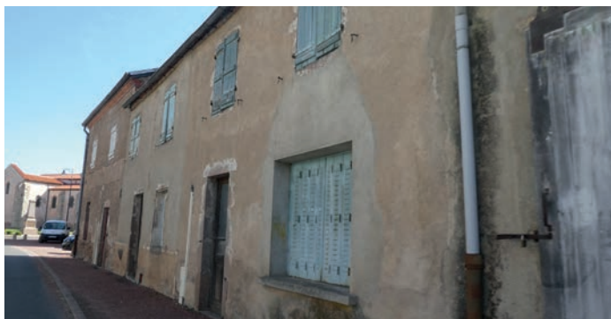
_Logement vacant à Droiturier
