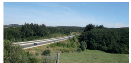
La RN7, élément de fragmentation, à Droiturier
