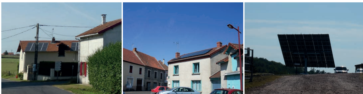
_Panneaux photovoltaïques sur une construction à Andelaroche
