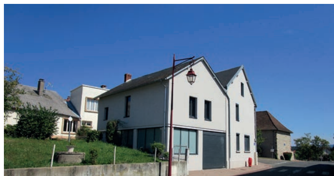
_Réhabilitation d'une habitation dans le centre-bourg d'Isserpent
