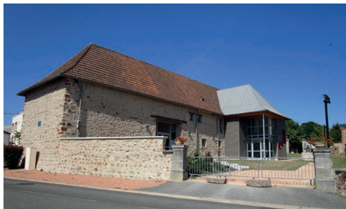
_Bâtiment rénové à Isserpent
