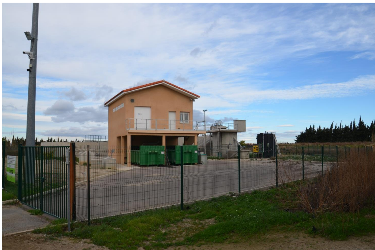
☞ Photo : Station d'épuration de Clair
