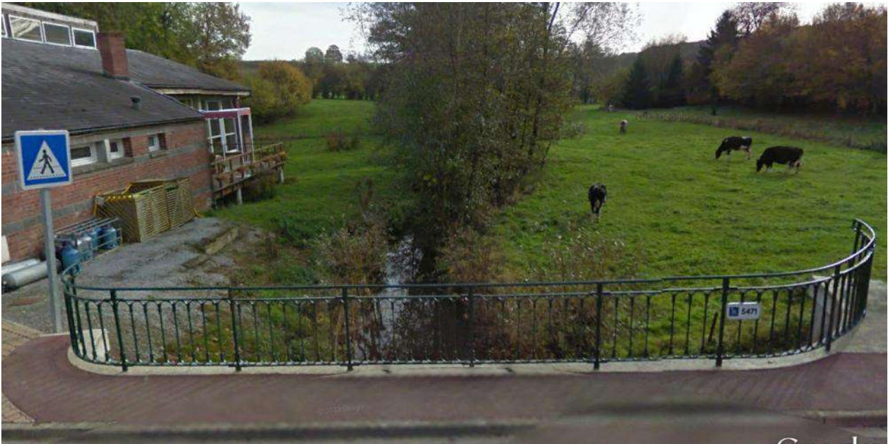
Figure 3 : La Thure au pont de la D962 à Hestrud, maison en zone inondable [Source : IMS RN ]
