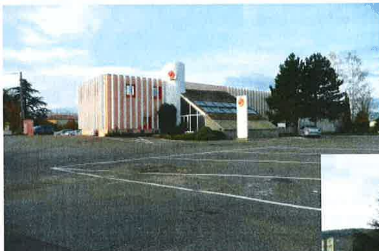
Bâtiments existants sur cette zone.
