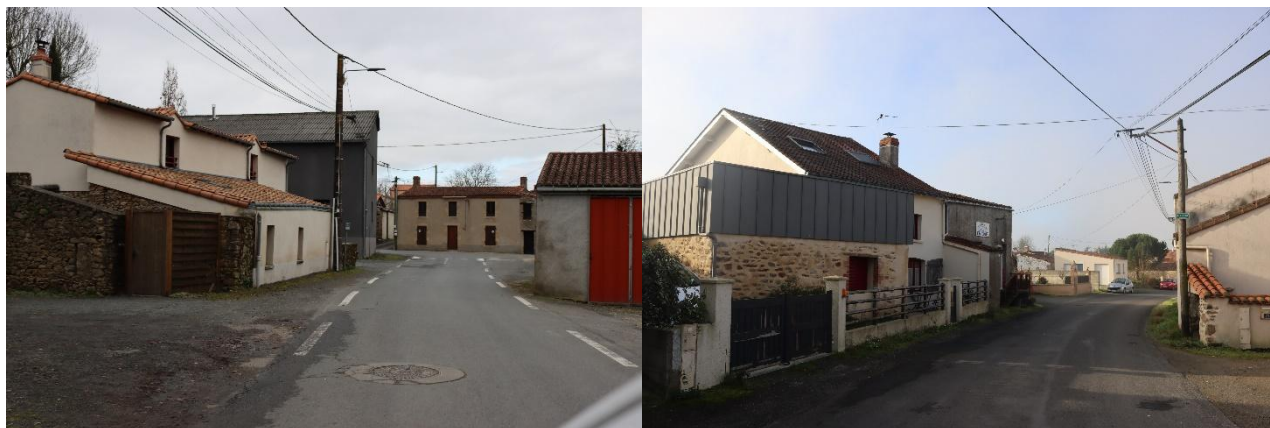
Photo 50. Quelques exemples d'aménagements déconnectés de l'architecture traditionnelle
