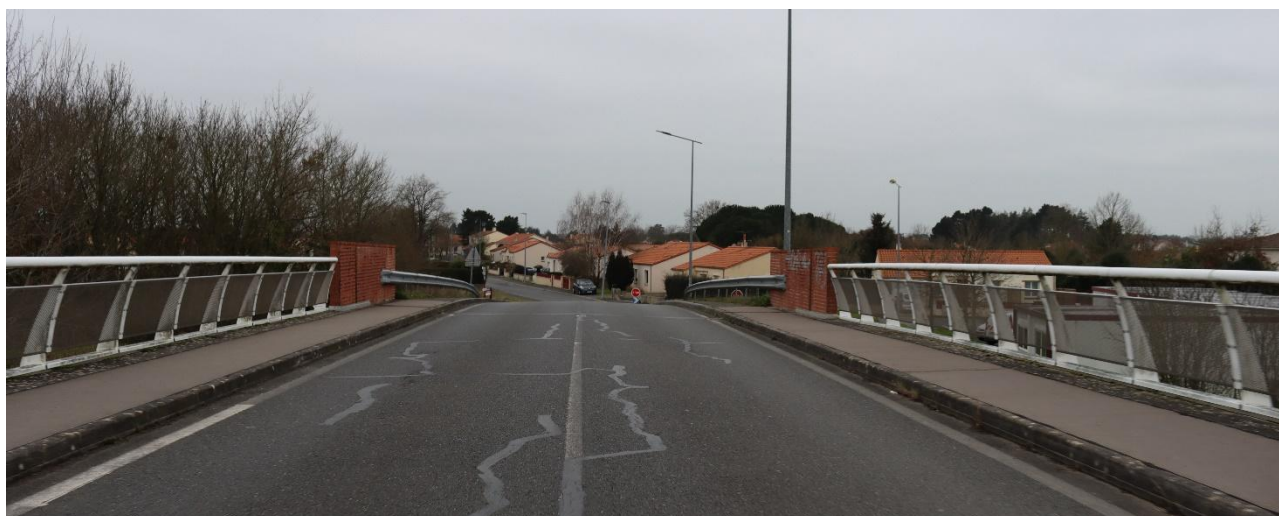
Photo 31. Entrée nord (route de la Brebionnière) caractérisée par le passage au-dessus de la D149
