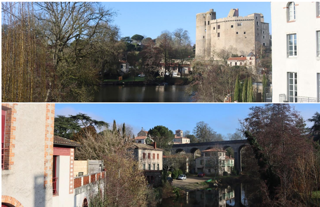
Photo 13. Depuis le pont Saint-Antoine : vue sur le château et le viaduc enjambant la Moine
