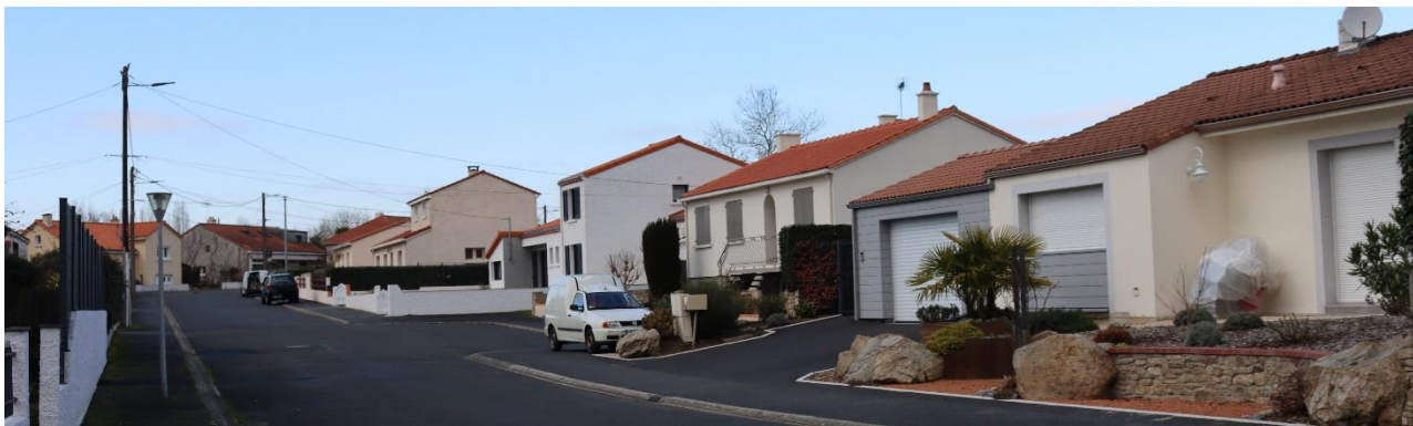
Photo 22. Quartier d'habitation récent
