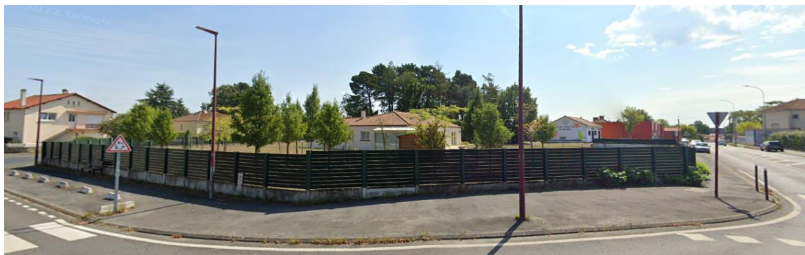
Figure 5. Vue depuis la rue du Moulin, au Nord
