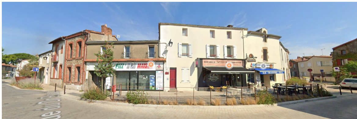
Figure 6. Vue du front bâti depuis le sud du site
