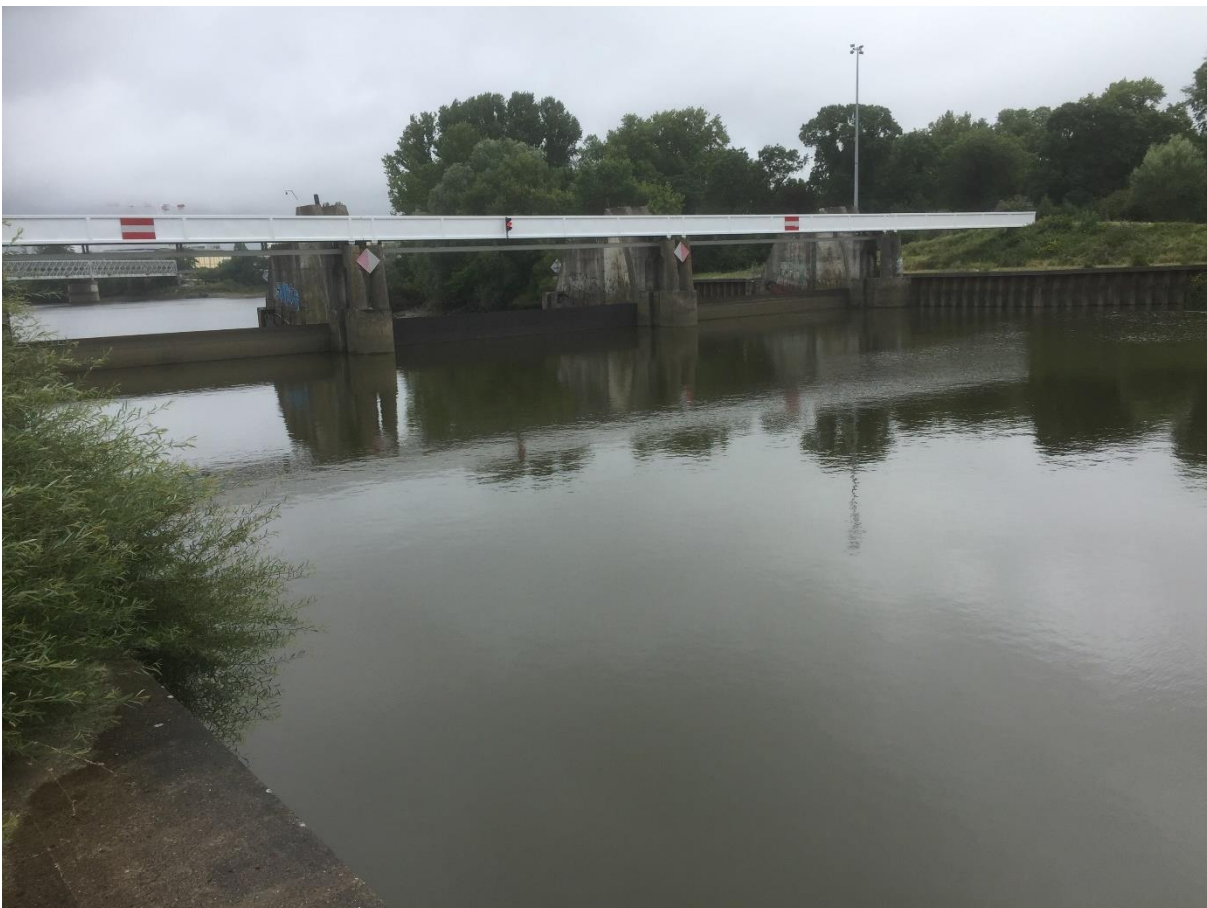
Figure 22 : Photo du barrage de Pont Rousseau (source : Suez Consulting)
