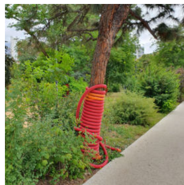
Exemple d'un arbre protégé à proximité d'un chantier
