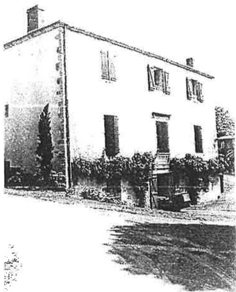
Enduits laissant les pierres d'angle apparentes.
