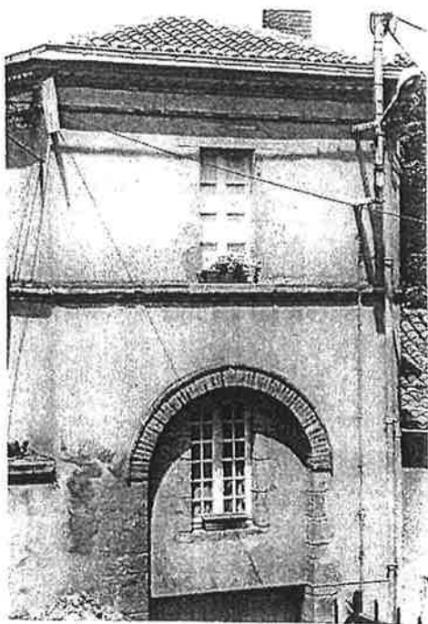
La brique au niveau inférieur
