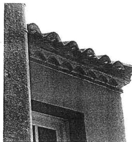
Génoises en briques, reprises en maçonnerie
