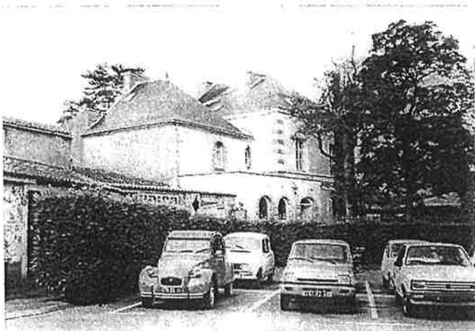
La pente des toitures ardoises
