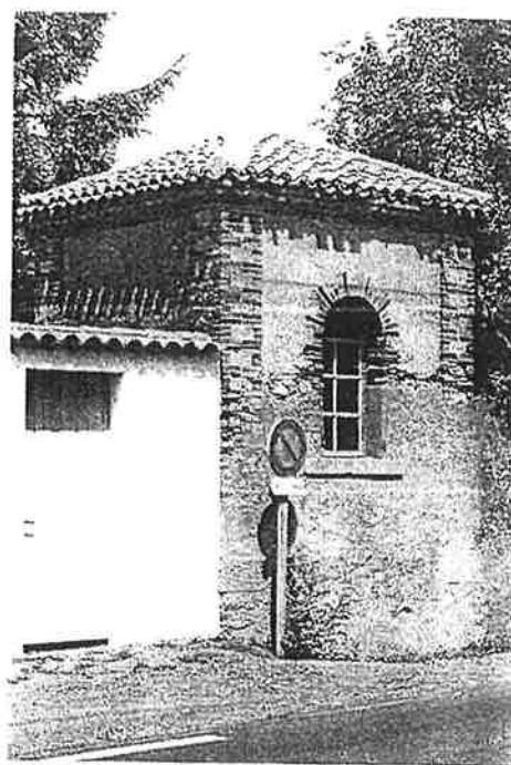
Génoises de briques et tuiles
