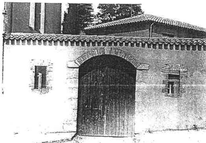
Arc segmenté en briques et granite
