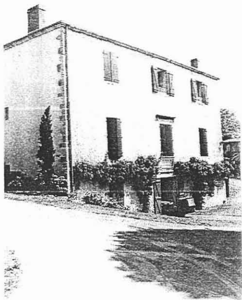
Enduits laissant les pierres d'angle apparentes.
