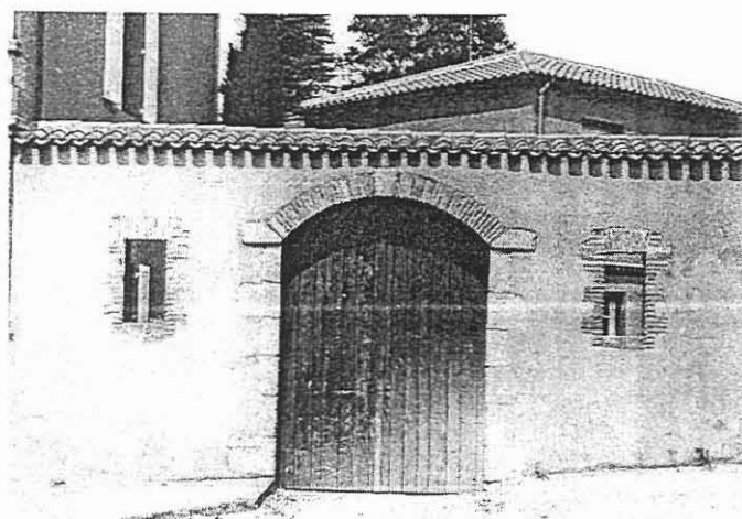
Arc segmenté en briques et granite
