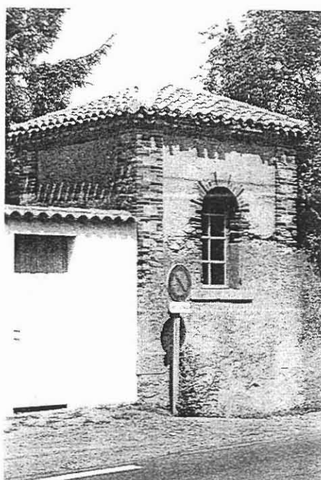
Génoises de briques et tuiles
