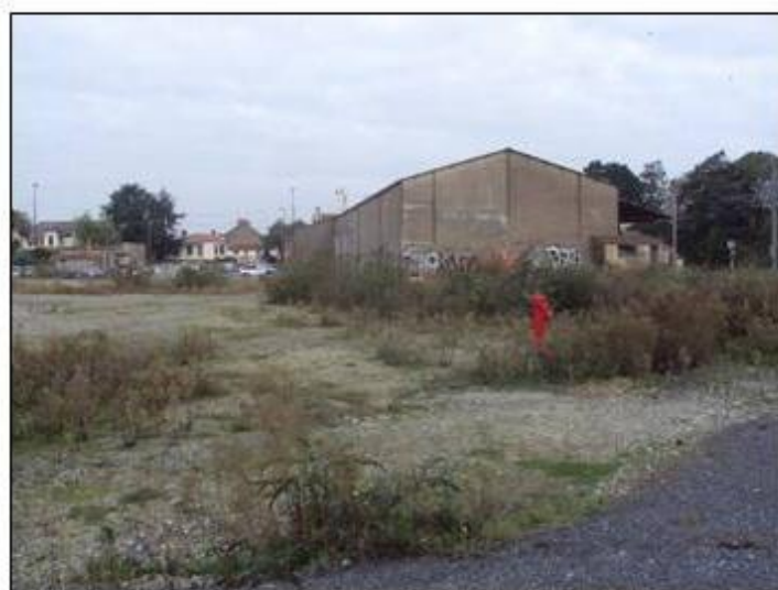
16 – Bâti existant de stockage de grain le long de la voie ferrée à coté du parking actuel champ de foire
