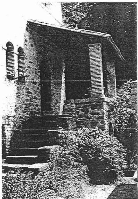
Escaliers extérieurs Entrée couverte par un appenti.
