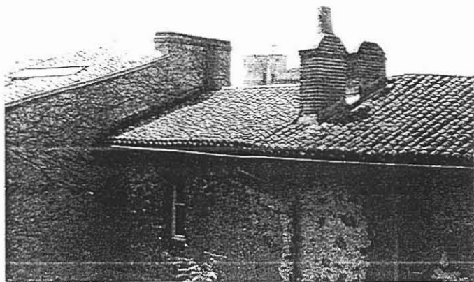
Toitures en tuiles traditionnelles à noter les formes des cheminées
