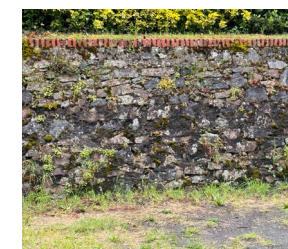
Mur en maçonnerie de pierre locale et couronnement en brique
