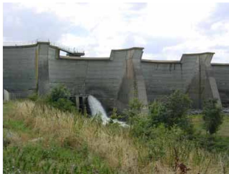
Le barrage du Verdon
