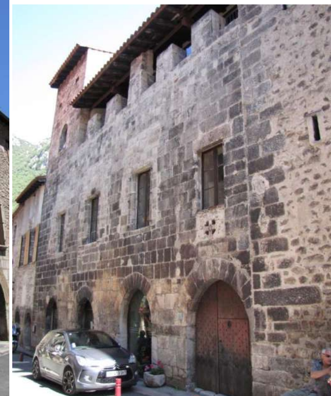
38 rue Saint-Jean – Ancien hôpital
