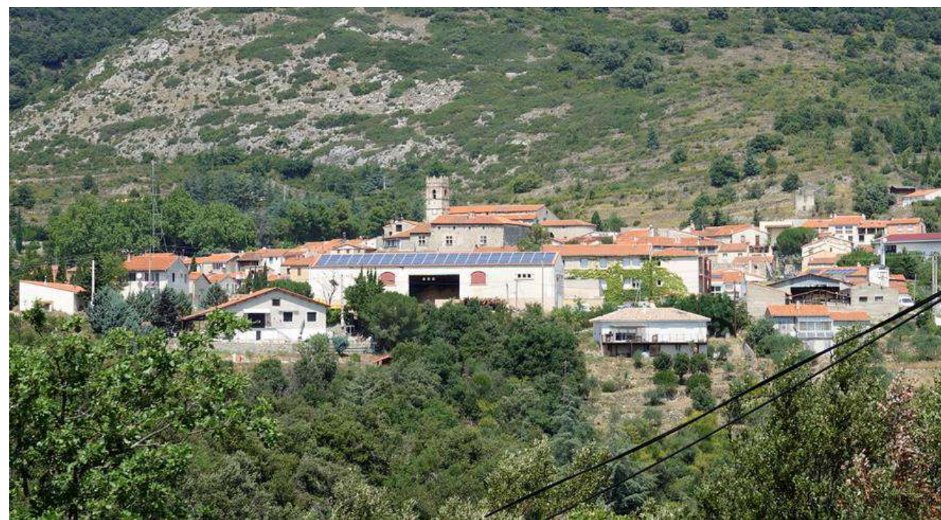
Sournia : altération du site par la présence d'une construction hors d'échelle
