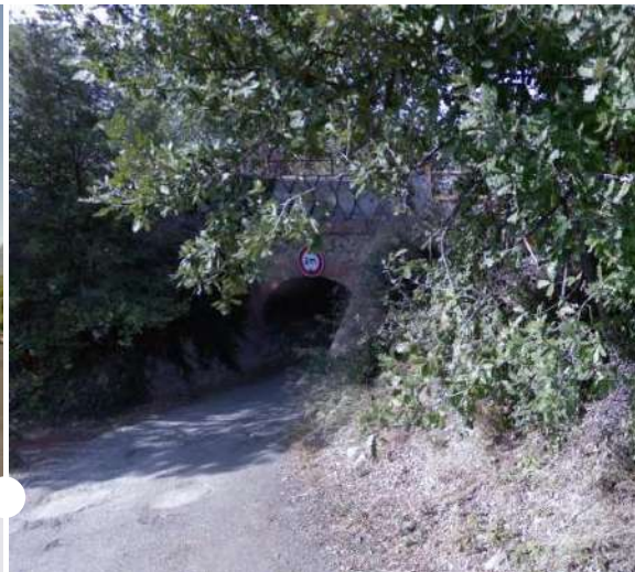
Passage sous la voie ferrée
