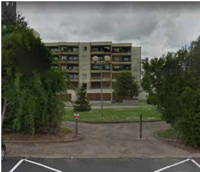
Paron / Un ensemble collectif avec des espaces de stationnements rejetés en bordure de rue, les espaces communs entre les bâtiments sont plantés et exclusivement piétons.
