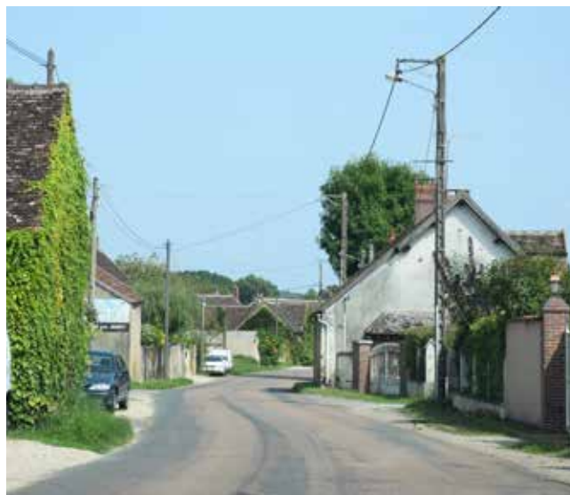
Marsangy / Une implantation caractéristique des villages-rues avec une présence visuelle du végétal depuis la rue (façades, cours et jardins, accotements). Enjeu de la sécurité des cheminements piétons.
