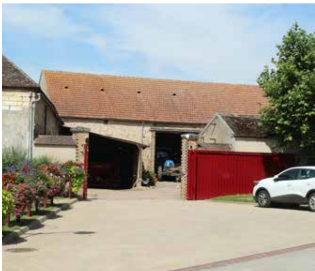
Gron / Un bâtiment agricole en plein coeur de village, caractéristique d'une forte identité rurale : la question de la pérennité des activités agricoles enserrées dans les tissus urbains et de leur reconversion en logements sur le long terme.
