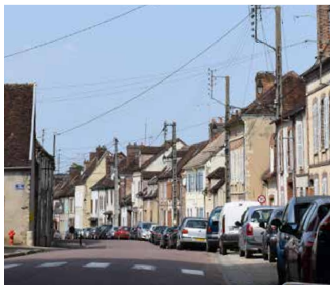
500 Villeneuve-sur-Yonne / Un axe de faubourg aux bâtis anciens resserrés et de hauteur variable, une voie large, mais un empiètement total des voitures en stationnement sur le trottoir.
