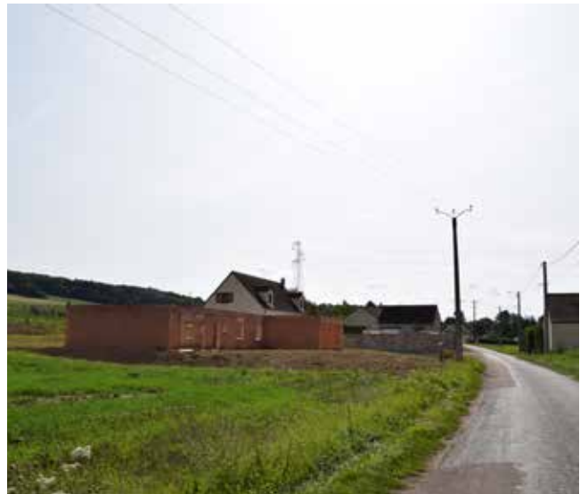
Collemiers / Un pavillon en construction en bordure de ville, entouré de champs.
