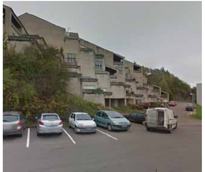
Paron / Un ensemble collectif massif, mais qui tend à respecter la pente du coteau par ses volumes en escalier. Les espaces extérieurs sont exclusivement consacrés au stationnement.
