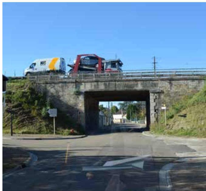
D15 entre Les Bordes et Villeneuve-sur-Yonne
