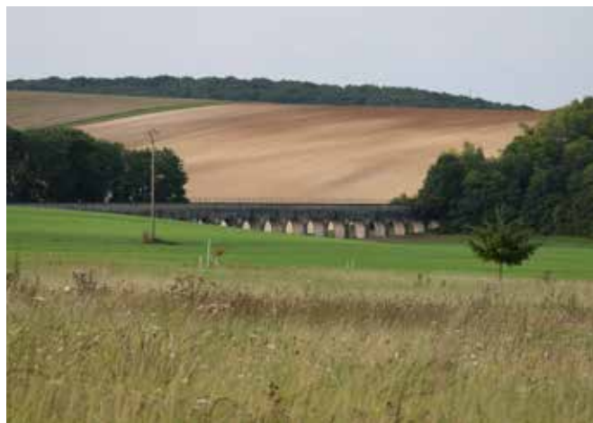
Les ouvrages de l'aqueduc ponctuent la vallée de la Vanne
