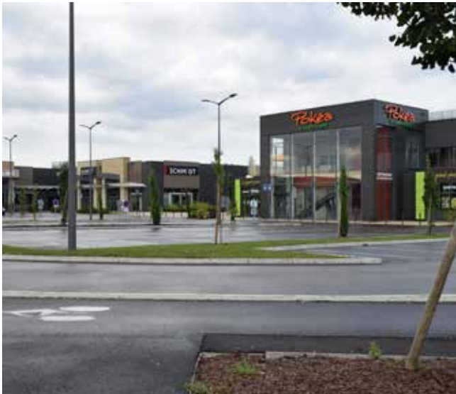
Zone commerciale Sens Sud / D'importantes surfaces imperméabilisées dédiées au stationnement
