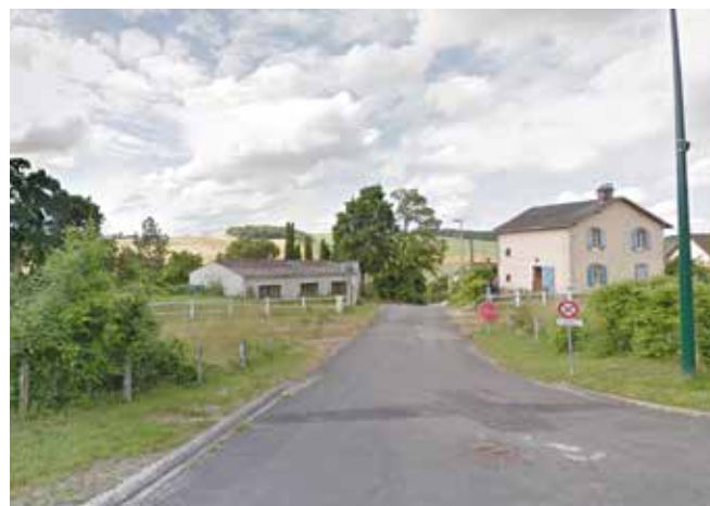
La voie de chemin de fer désaffectée longe la vallée du ru de Subligny
