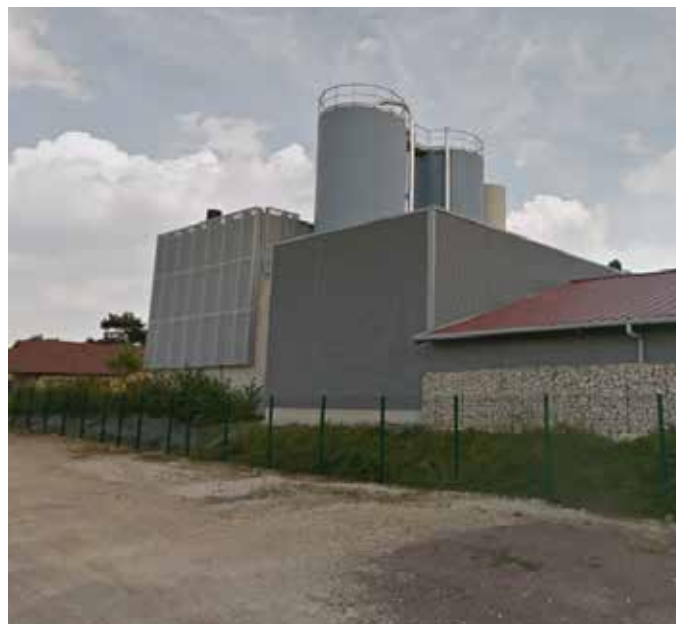
La station d'épuration à Saint-Denis-lès-Sens
