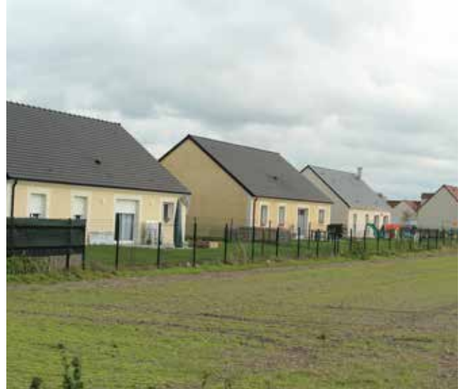
Sens / Une succession de pavillons individuels identiques, implantés sur de très petites parcelles qui impliquent une absence d'arbres. Chaque terrain est clôturé et la relation à l'espace agricole n'a pas été travaillée.
