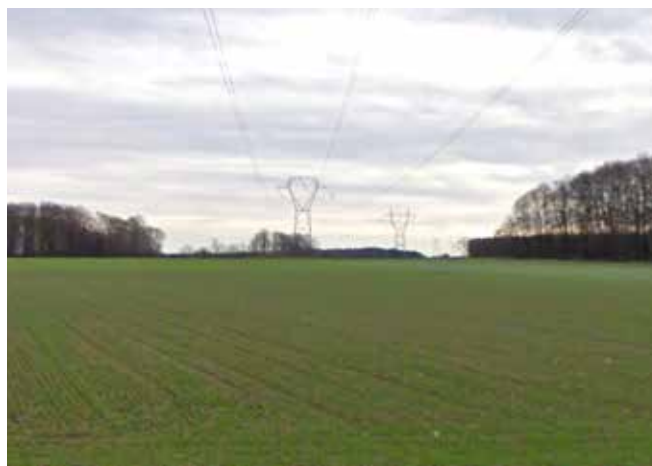
Les lignes à haute tension traversent la commune de Dixmont en entaillant la forêt de la Briffe
