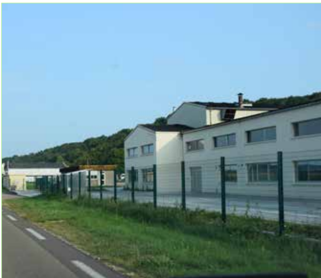
Zone d'activités Vallée de la Vanne
