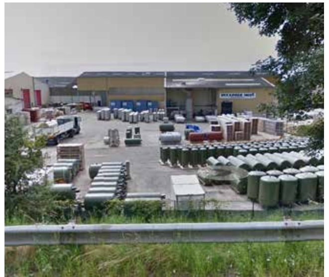
Zone industrielle des Sablons / De vastes espaces de stockage extérieurs
