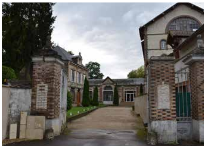
À Sens, les briques participent au caractère chaleureux de l'architecture
