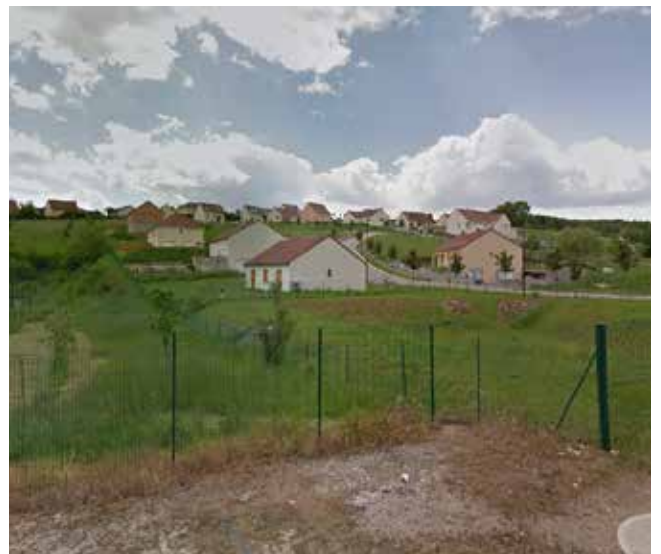
Saint-Martin-du-Tertre / Un lotissement implanté sur le coteau avec un fort impact paysager.
