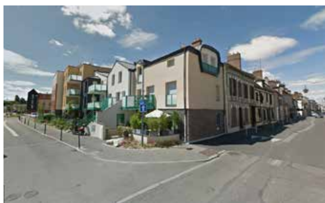
Rue du Général de Gaulle / Un bâti récent hétéroclite qui s'adapte aux gabarits alentour.
