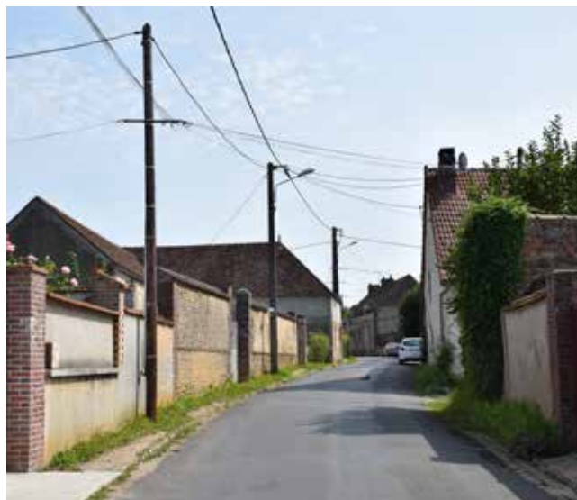
Hameau à Villeneuve-sur-Yonne / Un alignement continu sur la rue par les murs d'enceinte des cours. Un trottoir enherbé à caractère rural, mais quasi inexistant. En arrière-plan, une longère agricole implantée perpendiculairement à la rue.
