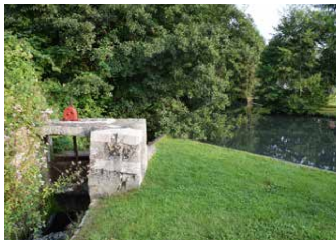
À Malay-le-Grand, les ouvrages liés à l'eau constituent un véritable patrimoine
