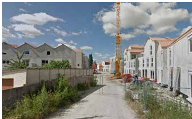
Rue de Gravereau / Une mixité de typologies dans cette opération en construction.
