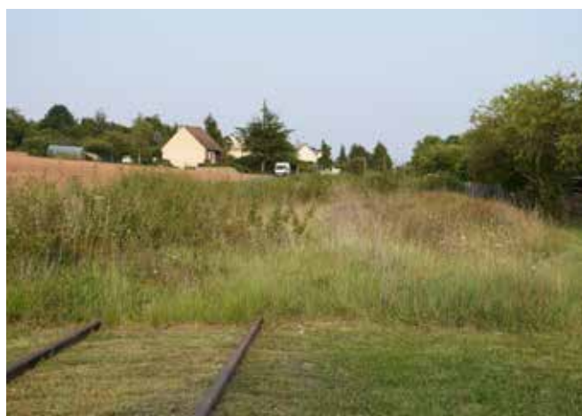
L'ancienne voie de chemin de fer à Malay-le-Petit
