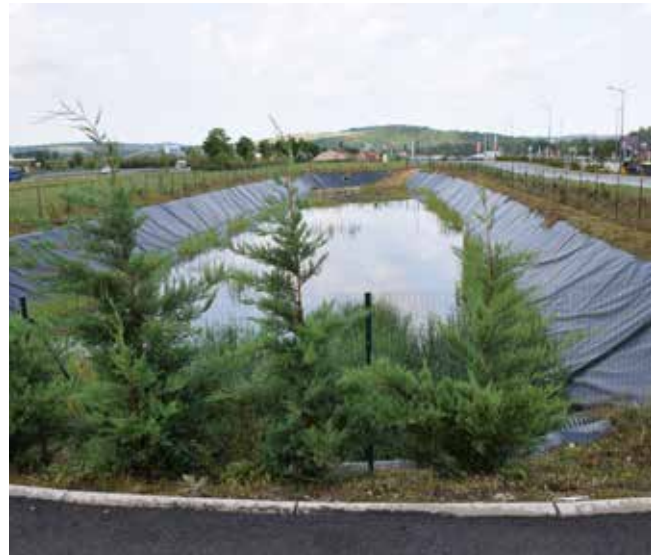
Zone commerciale Sens Sud /Un bassin de rétention pour gérer les eaux pluviales qui ne s'infiltrent plus dans le sol
