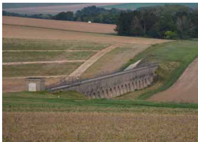
L'arcade de Beauregard permet de franchir les Vaulissons dans la vallée de la Vanne
