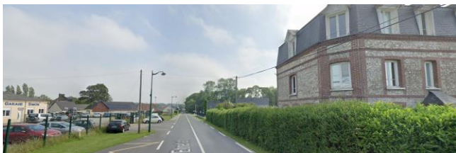
Vue depuis la route d'Etretat sur le garage actuel et l'habitation voisine
