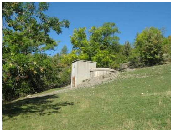
Figure 13 : Réservoir de Clignon Haut ( 50\text{m}^3 )
