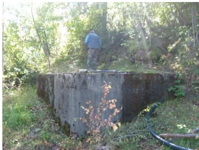
Figure 10 : Réservoir du Haut (8m 3 )
