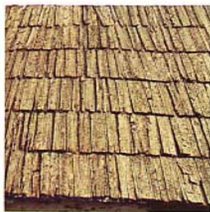
2 La vallée du Haut-Verdon Toiture en bardeaux de mélèzes.
