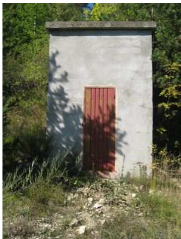
Figure 14 : Réservoir de Chaumie (100m 3 )
