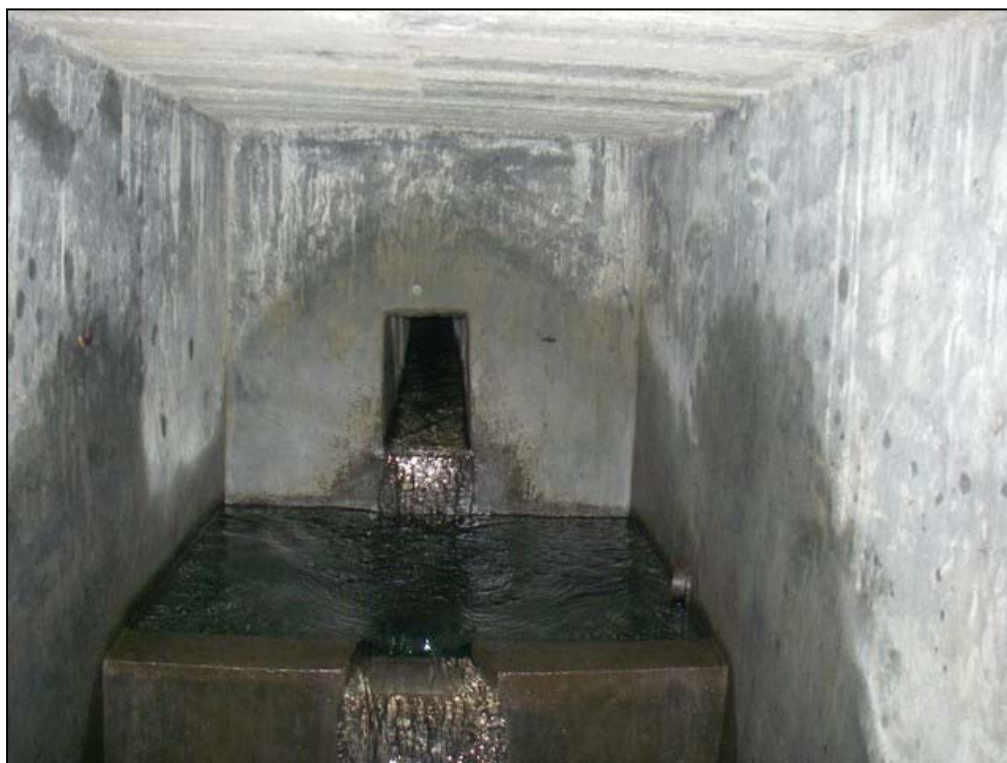
Photographie 2 : intérieur de l'ouvrage de captage
