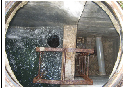
Vue intérieure du regard
