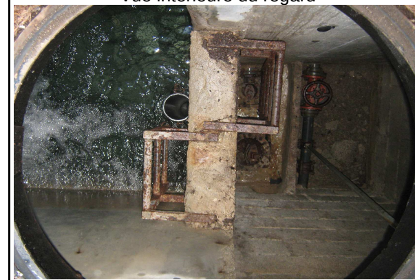
Vue intérieure du regard
