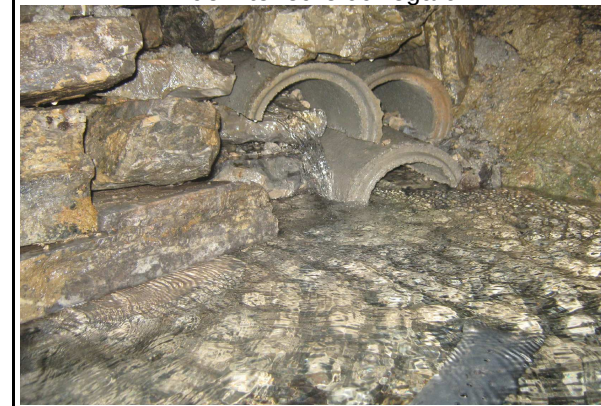
Vue intérieure du regard
