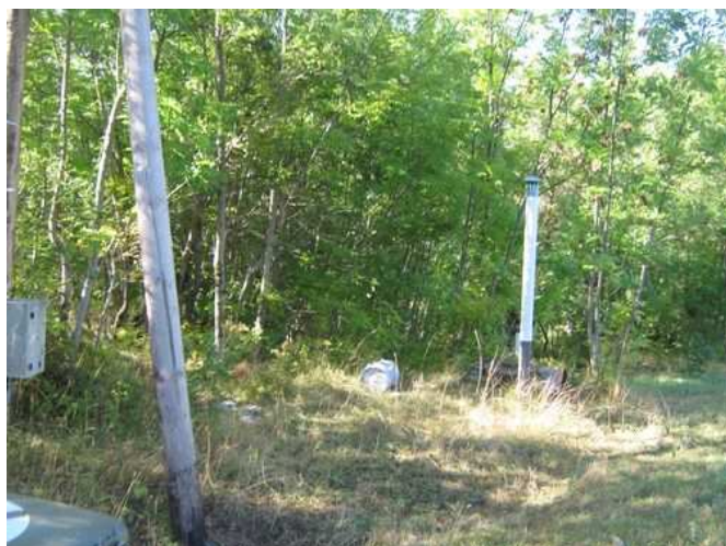
Figure 15 : Vue extérieure de la station de pompage
