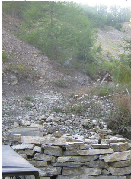
Captage de la source de Grabelong
