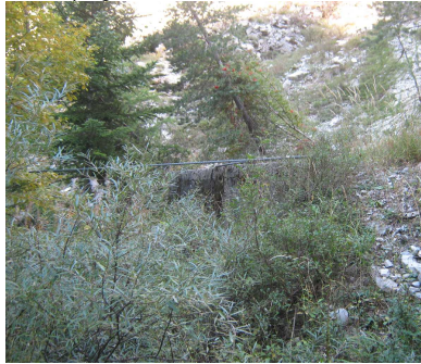
Captage de la source de Pont Misson
