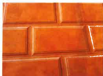
Exemple de décor en faux appareil (Cunéo)
