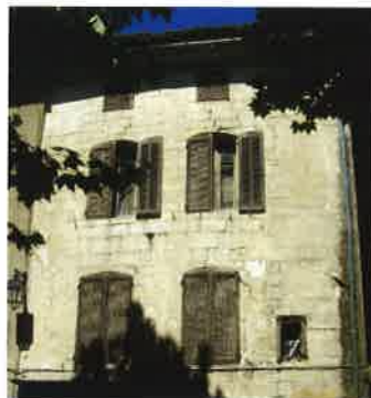
Mur en pierre de taille
