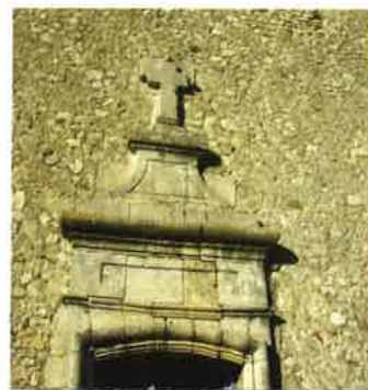
Mur de remplissage en moellons et décor en pierre de taille
