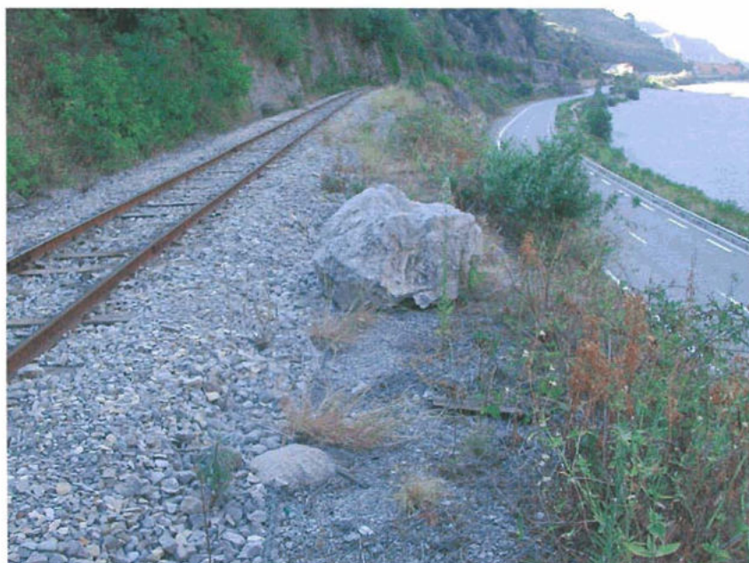
Bloc de 1 m 3 arrêté au bord de la voie ferrée à proximité du Chaudan
