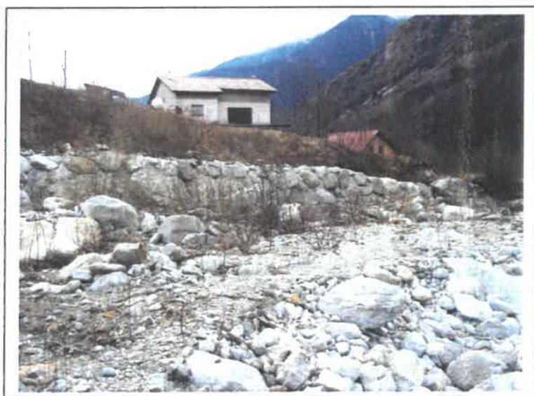
Photo n°10 : enrochements bétonnés pour protéger la berge. Le chalet au toit rouge en arrière plan est menacé par les crues de la Vésubie.
