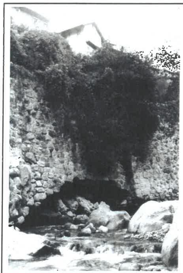
Cliché RTM-06, 1965 – photo n°2 : Digue affouillée par la crue du 1 er octobre 1965
