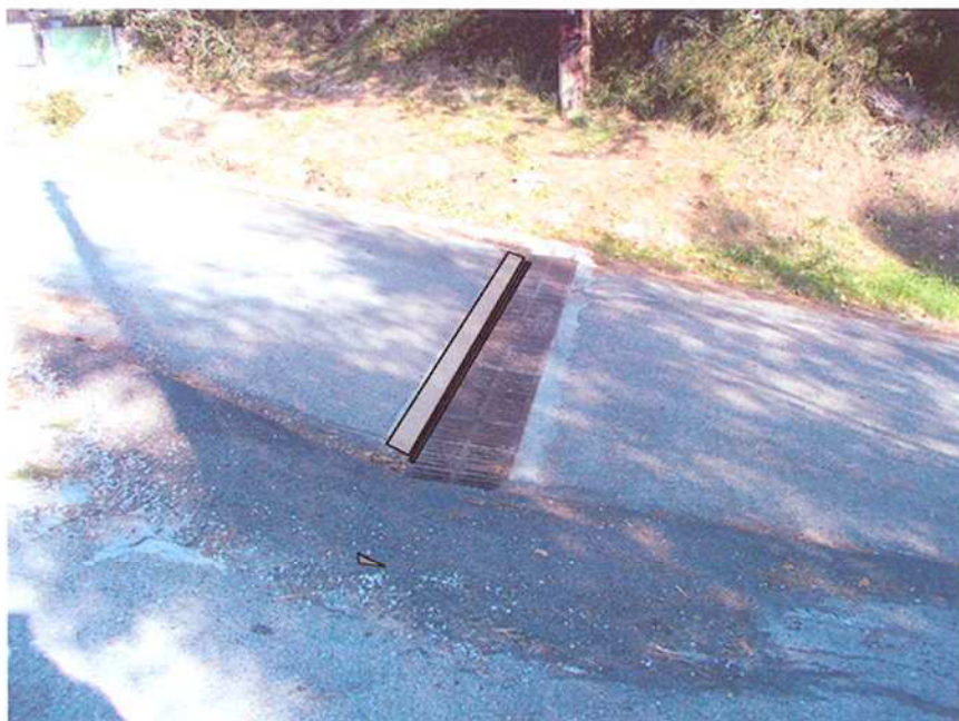
Photographie 5. Exemple de grille avec avaloir à construire au niveau du virage.
