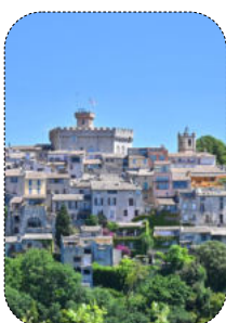
01 Les façades enduites
