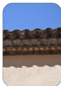
13 Les débords de toiture
