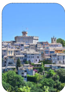
01 Les façades enduites
