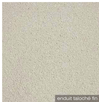
enduit taloché fin
