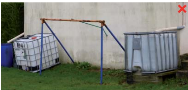
Exemple de cuves de récupération d'eau de pluie, non dissimulées, qui dévalorisent les façades.
