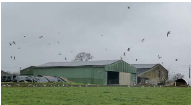
Privilégier le recouvrement complet des toitures par les panneaux solaires. Les granges, les bâtiments agricoles, peuvent être équipés de ces systèmes.
