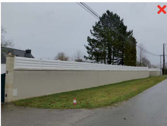
Exemple de disproportion entre le mur bahut et la palissade. Cette dernière en PVC blanc appauvrit la qualité de la clôture.
