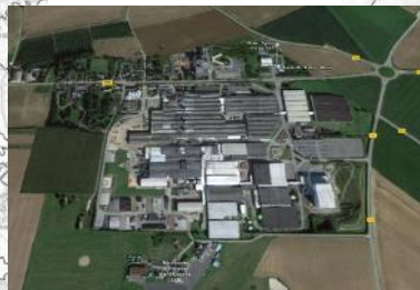
Site Bonduelle, Estrées-Mons, classé SEVESO seuil bas
