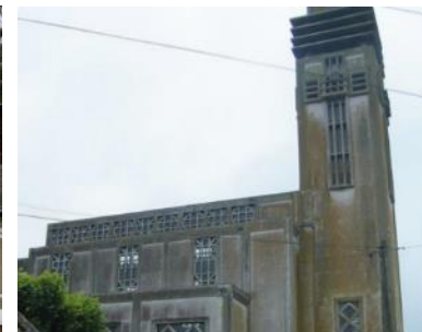
Patrimoine de la reconstruction : église de Brie
