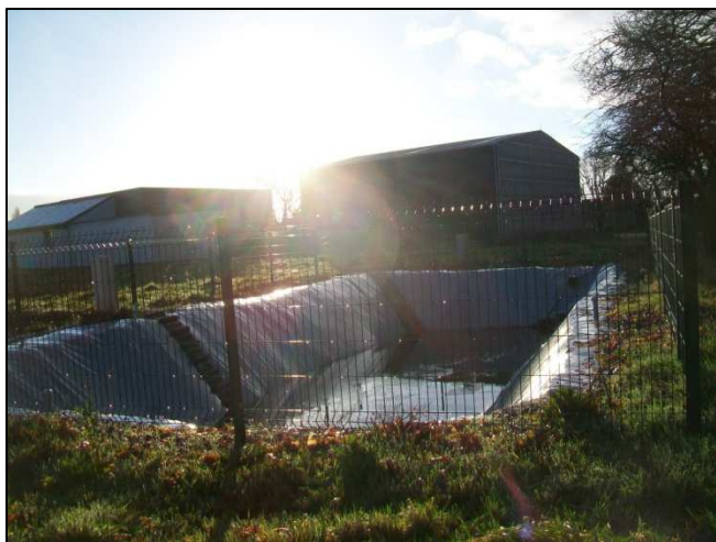
Bassin de rétention
