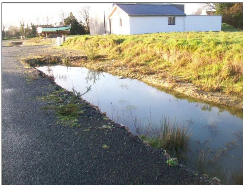
Noues d'infiltration avant le bassin
