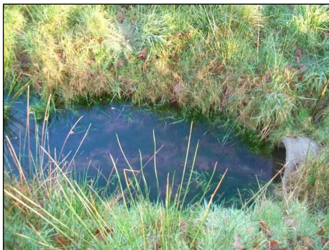
Exutoire de la noue
