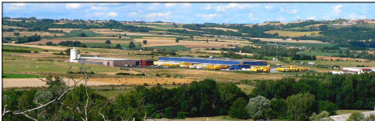
Le bassin de Combronde sur lequel s'aménage le Parc de l'Aize
