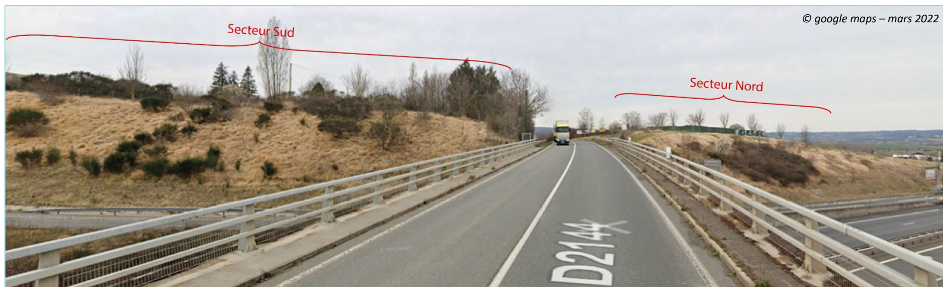
Vue sur les secteurs d'étude depuis le pont franchissant l'A71 (sens Est-Ouest)
