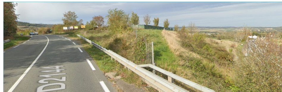
Vue en direction du secteur Nord depuis le pont sur l'A71 - ©google
