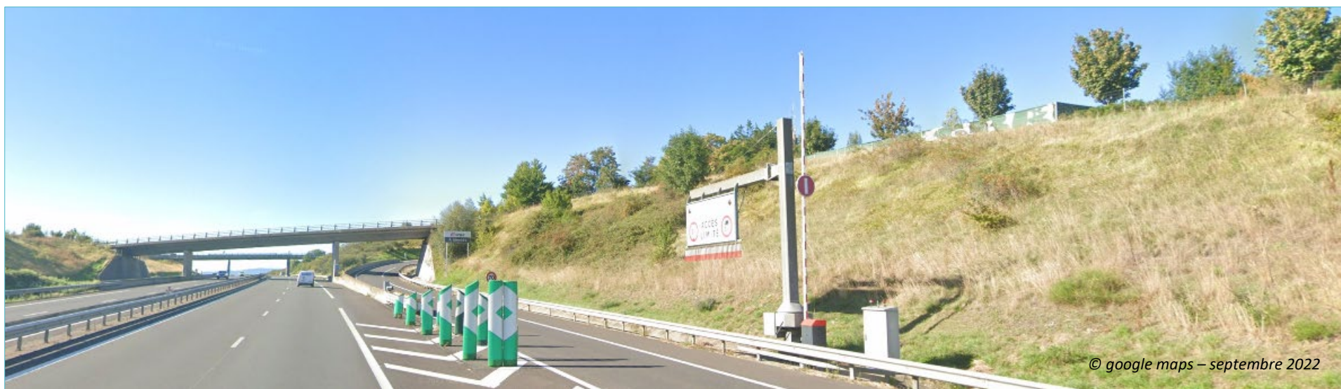
Aperçu du secteur Nord en surplomb de l'autoroute A71 (sens Nord-Sud) – perception atténuée par le cordon végétal
