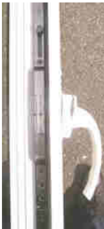
② Fermeture centrale (crémone et tringle)
