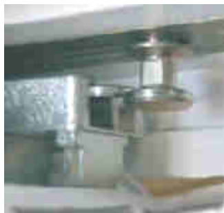
⑤ Gâche métallique de sécurité anti-décrochement et galet champignon
