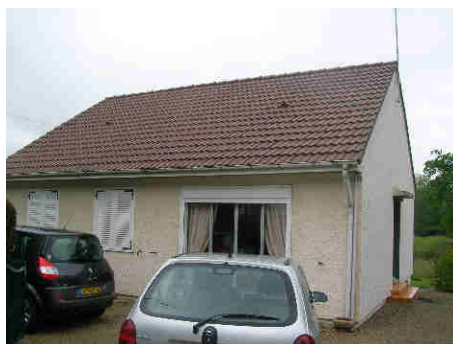
Photo 5: Exemple d'habitation sans étage
