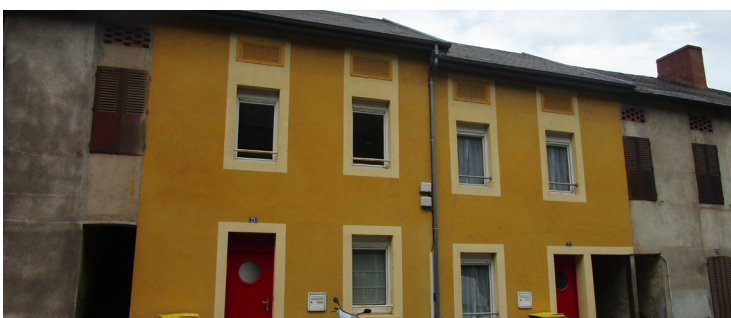
- Réhabilitations à Commentry -
