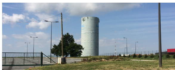
Réservoir d'eau potable à Montmarault [Source : Cittànova]
