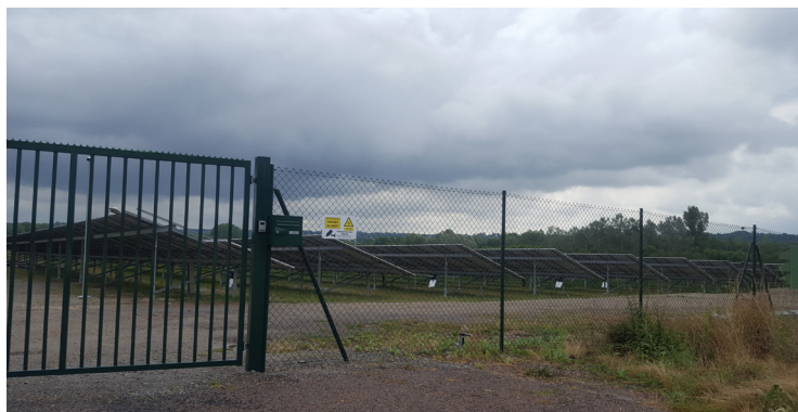
- Centrale solaire à Doyet -
