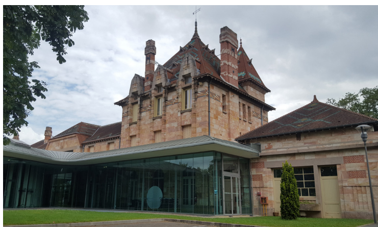
- Le pavillon du lac à Nérès-les-Bains -
