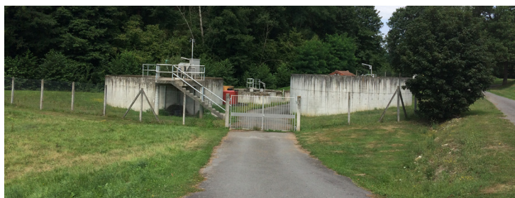
- Station d'épuration à Bézenet -
