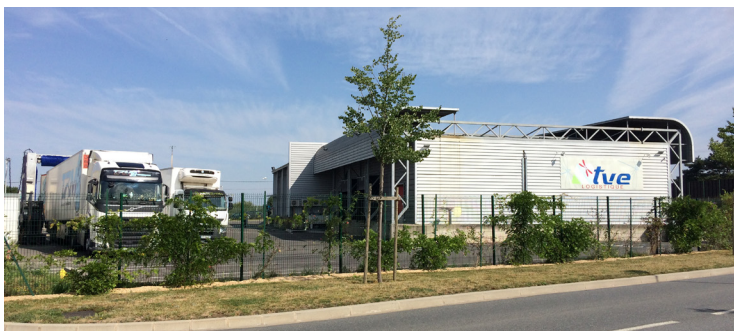
- L'entreprise TVE Logistique à Montmarault -
