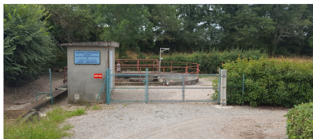
- Station d'épuration à Montvicq -
