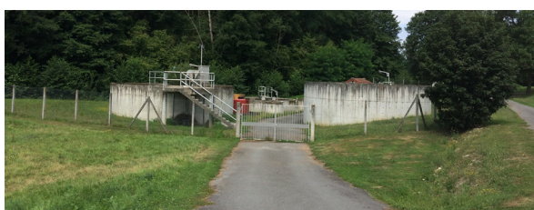
Station d'épuration à Bézenet, [Source : Cittànova]
