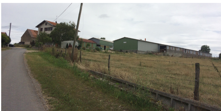
- Site d'exploitation agricole à Bézenet -
