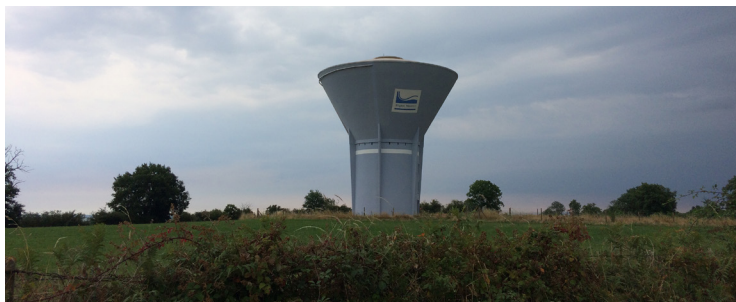
- Réservoir d'eau potable à Beaune-d'Allier -
