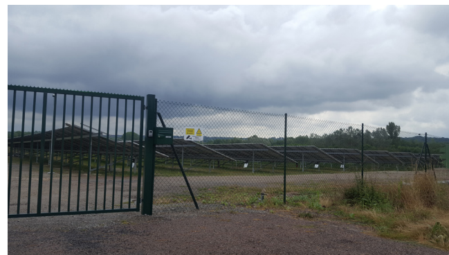
Centrale solaire au sol, Doyet [Source : Cittànova]
