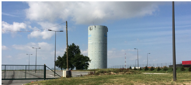
- Réservoir d'eau potable à Montmarault
