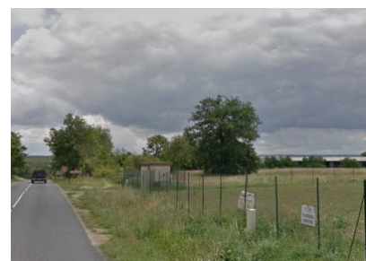
- Entrée de ville Ouest de Cosne-d'Allier -
