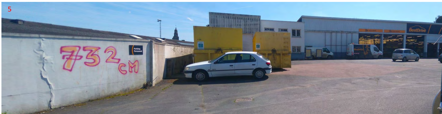
Vue lointaine depuis l'angle du Boulevard d'Eindhoven et de la rue du Dr Michel (zone d'activités)
