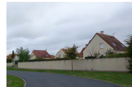
Murs hauts et enduits
