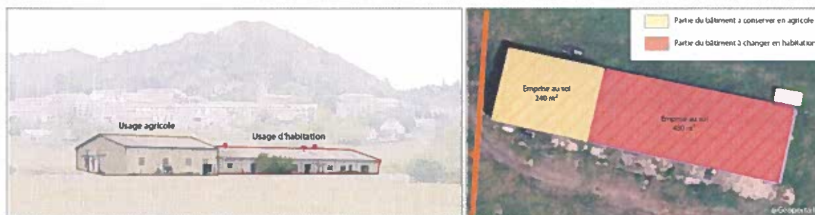
Usages du bâtiment – Cliché CCPA, mai 2021
