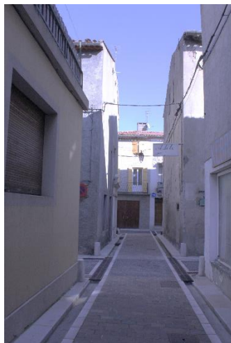
Rue Michelet (après travaux)
