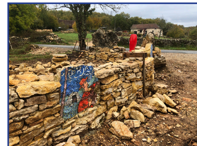
RESTAURATION EN COURS
