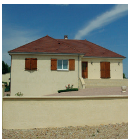
Urbanisation récente à l'entrée Ouest du village, près de la RD 2009
