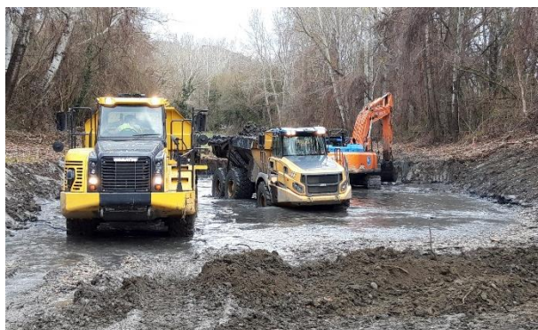
Terrassement, démantèlement de digue longitudinale, creusement de chenaux
