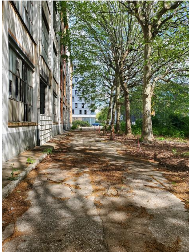
Figures 11 : Halle le long de la rue des Balançoires : ateliers de fabrication/bâtiment des conditionnements et expédition, platanes dans la cour à droite. 2023
