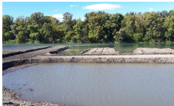
Réinjection sédimentaire, création de pistes et d'andins dans le Vieux-Rhône
