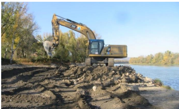
Terrassement, démantèlement de digue longitudinale, creusement de chenaux
