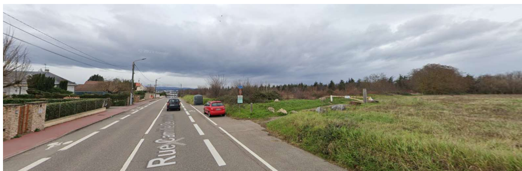
Figure 62 : Vue depuis la rue Camille Desmoulins
