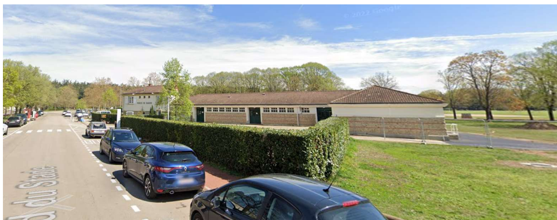
Figure 100: Photo du site depuis le boulevard du Stade, 2019
