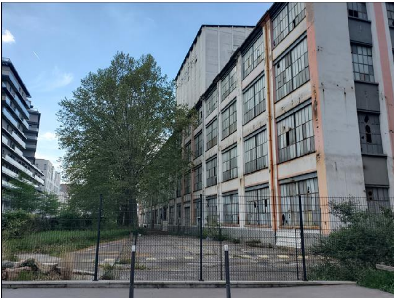
Figure 8 : Halle rue des balançoires (Soberco environnement, 2023)
