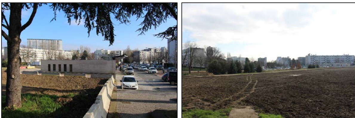
Figure 32 : Photographies du site actuel (après destruction des barres 520-530 (IN SITU – février 2021)
