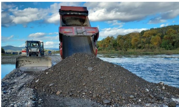
Réinjection sédimentaire, création de pistes et d'andins dans le Vieux-Rhône
