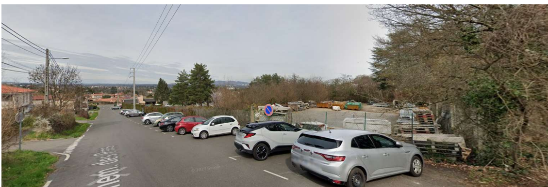
Figure 96: Photo du site depuis le chemin des Pins, 2023
